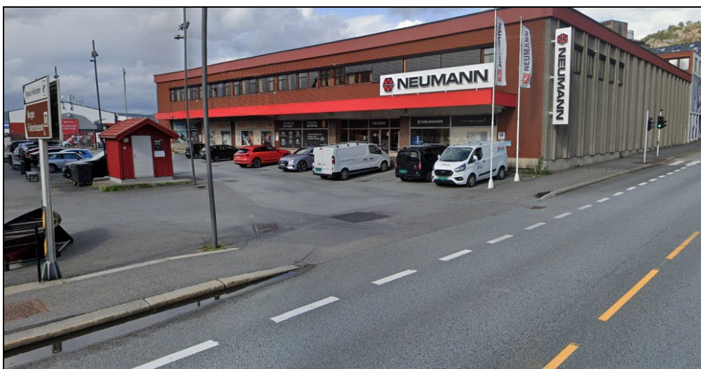
Figur 3. Avkjørselen i dag (Foto: Google).
