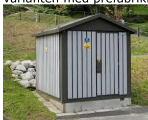
Figur 1 Frittstående nettstasjon(eksempel)
