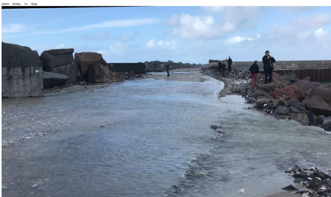
Figur 15 Vannstrøm som følge av bølgeoverskylling (Hirtshals). Vannmengden er stor nok til at uforberedt publikum vil oppfatte den som et vesentlig hinder. Godt utstyrte personer kan fortsatt ferdes på stedet. Antatt vannføring er 5 - 10 l/(sm)
