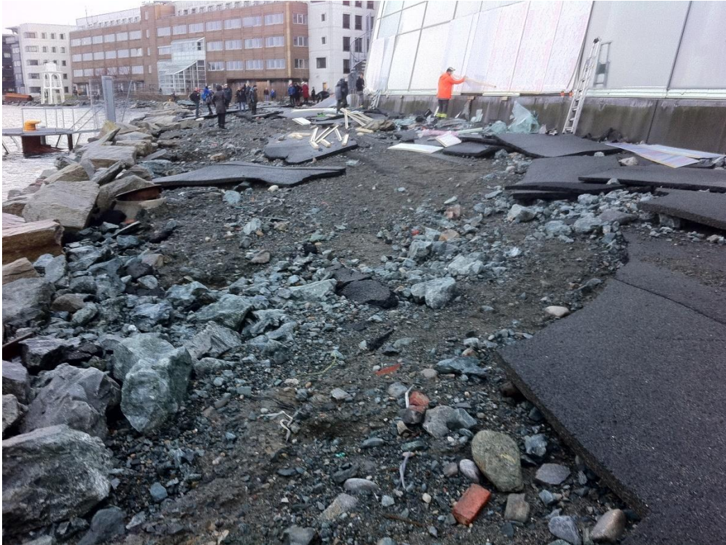
Figur 14 Skader etter storm ved Pirsenteret i Trondheim. Asfaltdekket er revet opp slik at grusdekket under er eksponert. Bølgene har løftet steiner opp og kastet dem mot glassfasaden.
