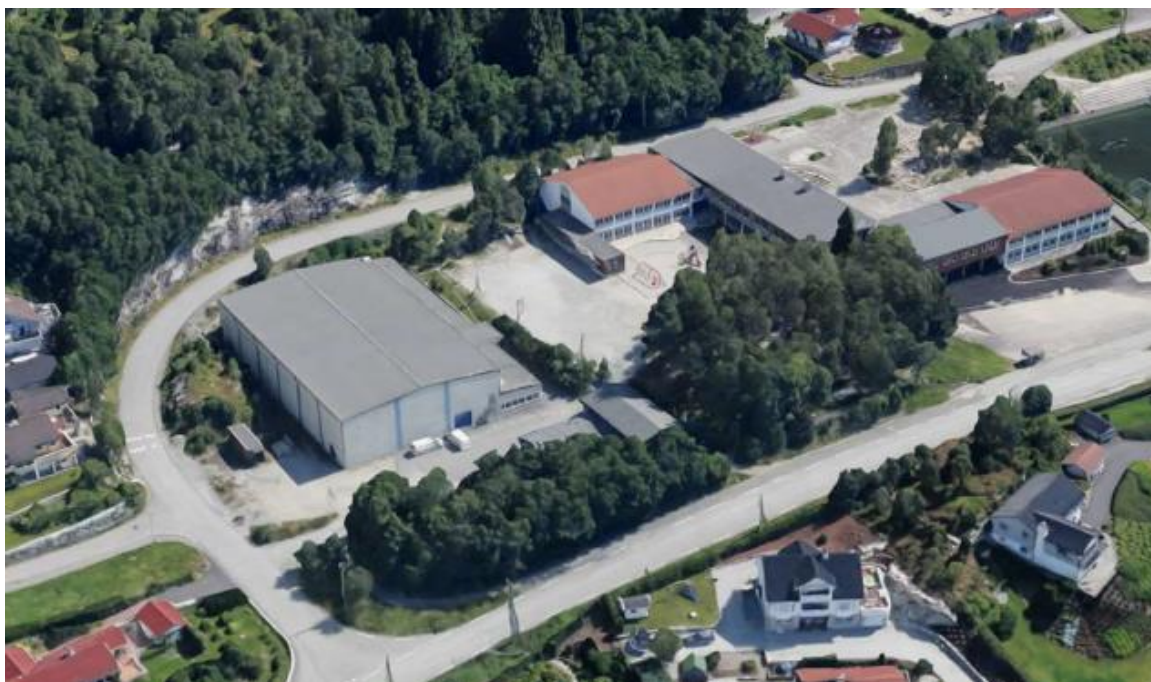
Figur 4-1: Bjørnarhallen og Garnes skole sett fra nordvest
