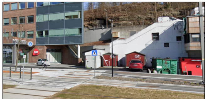
Figur 18: Foto av dagens byrom mellom delfelt S15 og S13. Trafostasjonene er rødmalt.
