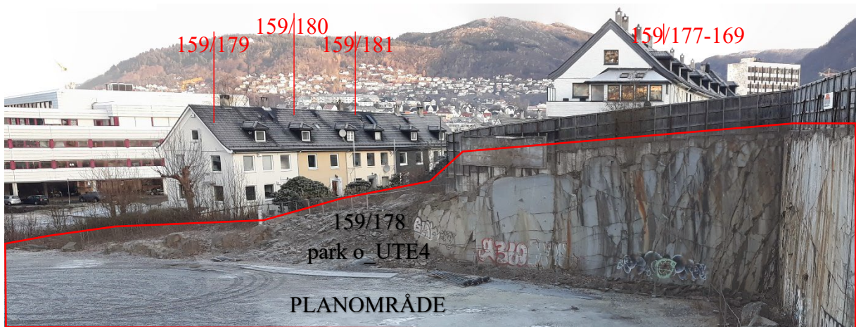
Figur 76: Bilde tatt i februar 2020 som viser arbeiderboligene på naboeiendommen, med vinduer som vender mot planområdet.
