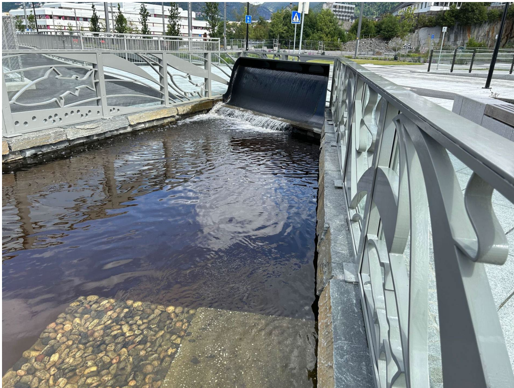
Figur 32: Kulvert under Kanalveien. Planområdet ligger øverst til høyre i bildet. Kilde: bt.no, 01.08.2023.
