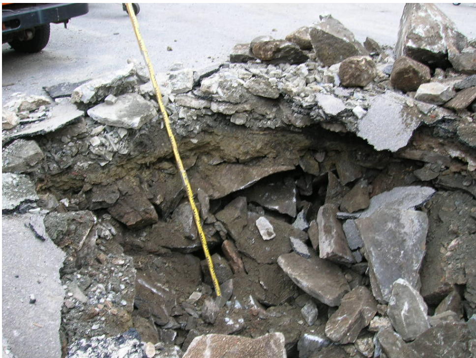
Figur 4: PG 3 inneholdt hovedsakelig stor stein og blokk. Det var lite finstoff i massene.
