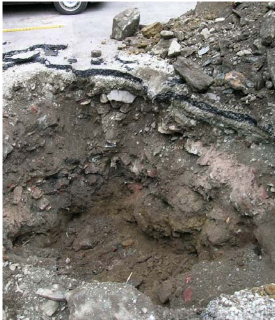
Figur 9: PG 6, blandede fyllmasser med en del teglstein og teglsteinsrester.
