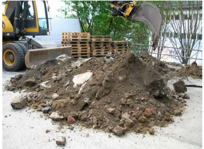
Figur 9: PG 6, blandede fyllmasser med en del teglstein og teglsteinsrester.
