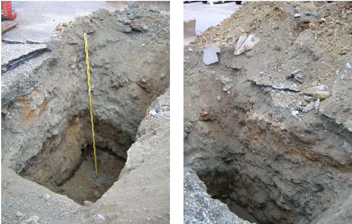
Figur 7: PG 5, avsluttet i ca. dybde 3 m. Mye av fyllmassene består av antatte morenemasser. Nederste ca. 1,3 m består av gul sand/finsand og torv. Dette kan være stedlige masser.
