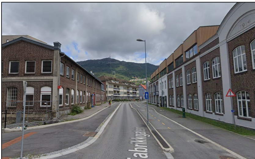
Figur 18 viser gatebilde fra den historiske bebyggelsen langs fabrikksgaten. Eksisterende påbygg fremstår som et fremmedelement.
