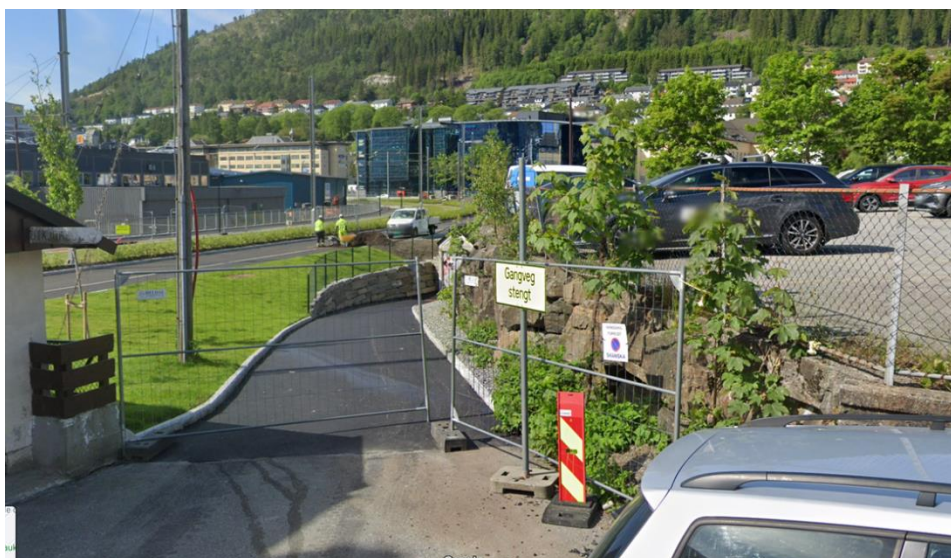
Figur 3: Adkomst til overløp
