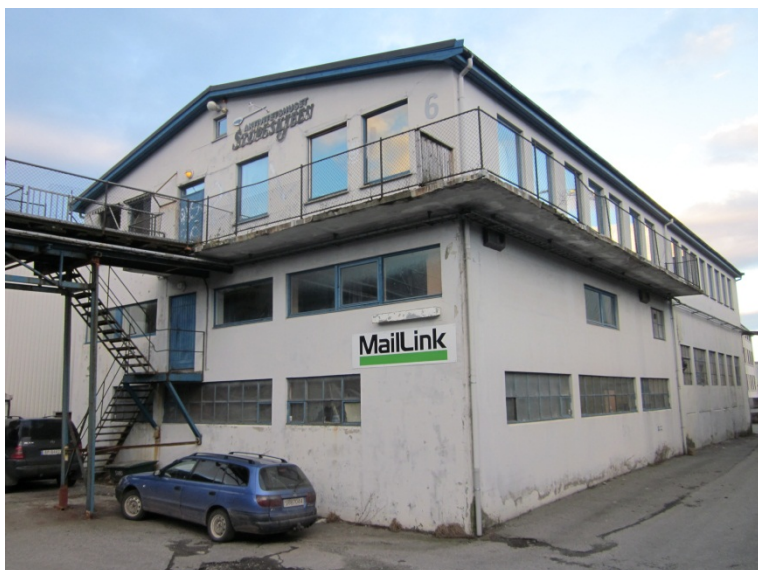
Figur 9. Del av støperiet og Fabrikkgaten 6 (nå revet)
