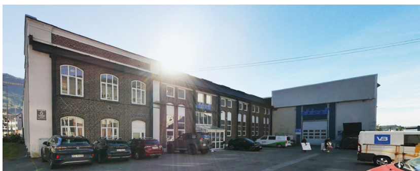
Fasade vest, vis-à-vis Kjeksfabrikken, er den opprinnelige teglfasaden. Mot sør og vest er det bygget til i flere omganger.
