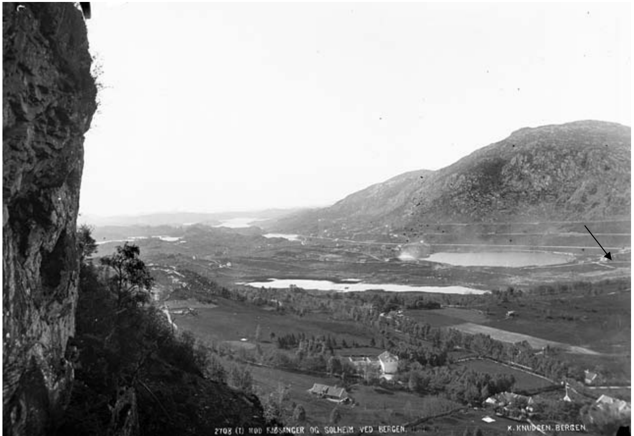
Figur 2. Mot Fjøsanger og Solheim ca. 1882-1885. Bildet er tatt mot sørvest og viser hvordan området så ut før det ble tatt i bruk til industri. De viktigste konstruksjonene i landskapet den gang var spredte boliger, et begrenset veinett og Vossebanen på vestsiden av Solheimsvannet. Planområdet ligger i og utenfor høyre bildekant, vist med pil. Fotograf: K. Knudsen & Co. Billedsamlingen, UiB
