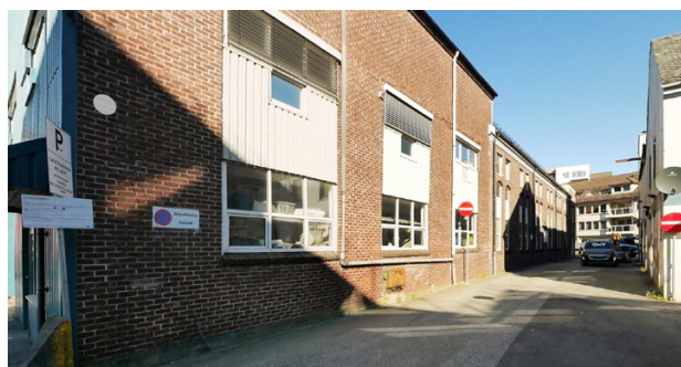
Sør for sidefløy i øst er seneste tilbygg utført i tegl
