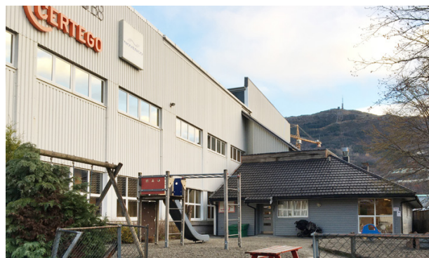
Sør for industrihallene er bygningsmassen tilført en barnehage i tre
