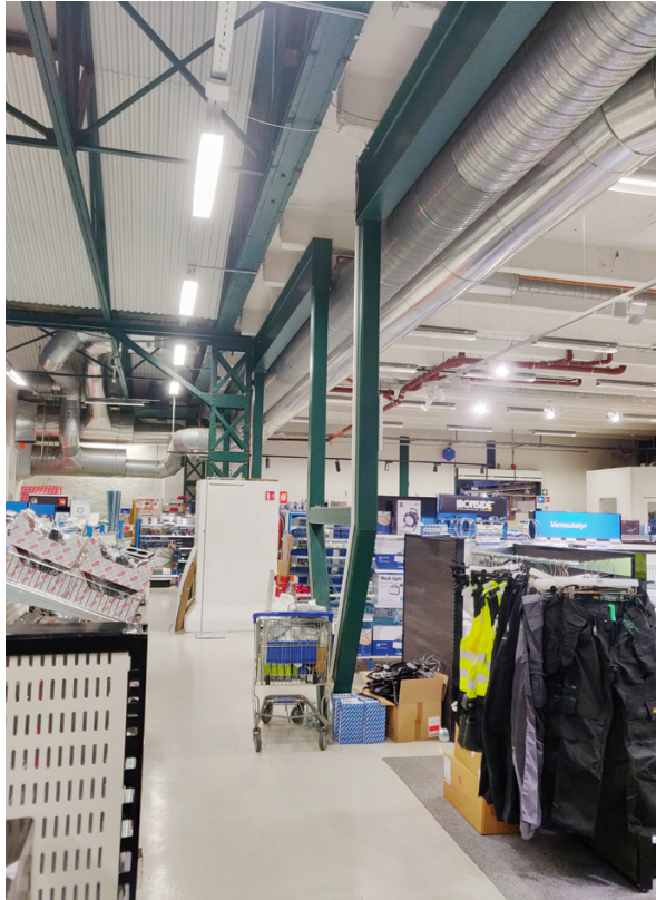
Sidefløy i vest: Opprinnelig bærekonstruksjon og vegger er fjernet på grunn av utallige ombygginger opp gjennom tidene, tilsvarende er gjeldende for sidefløyen i øst.
