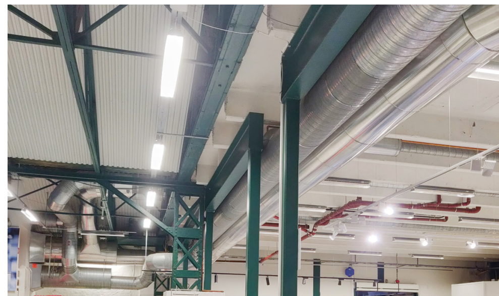
Sidefløyer, plan 1: Flere lag av konstruksjoner fra flere omganger med ombygginger. Opprinnelige bærekonstruksjoner er erstattet med DT-dekker og nye stålkonstruksjoner.
