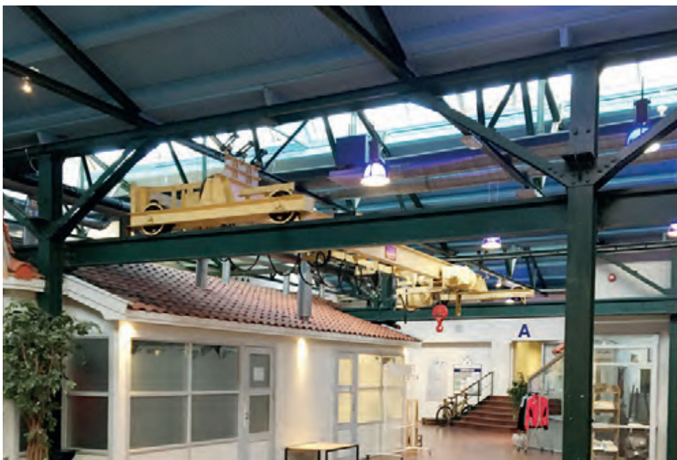
Stålkonstruksjonen i Fabrikkgaten 5. Kilde: Egne bilder
