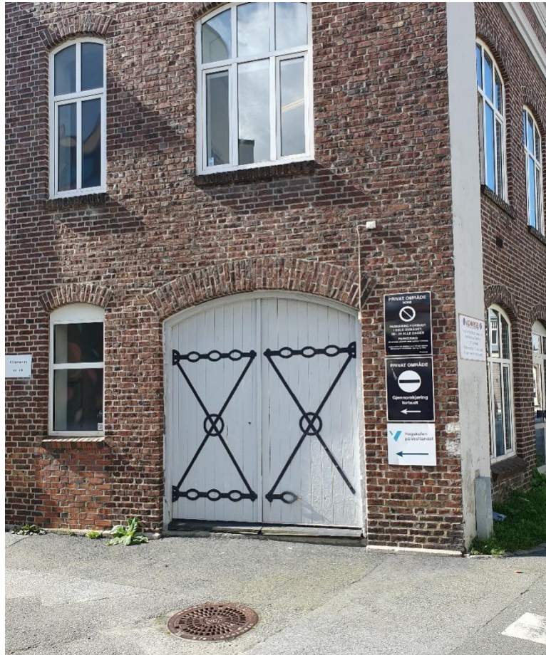
Figur 4-5. Fasadene langs o_GT i Fabrikkgaten 5.
