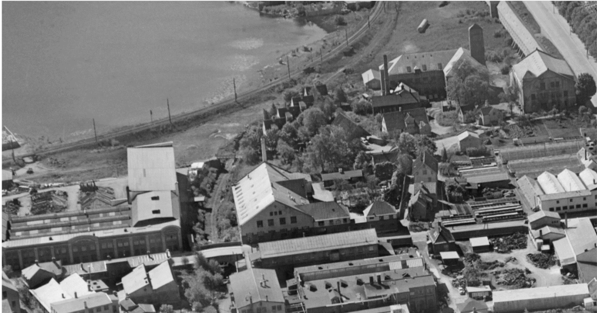
Figur 3-7. Bildet viser jernbanesporet slik det opprinnelig lå i skjæring frem til 50-tallet. Legg merke til at sporet går i kulvert under Fabrikkgaten. NSBs lokomotiv type 18, som ble brukt på Bergensbanen, har skorsteinshøyde på 4,1 meter. Kilde: Marcus.
