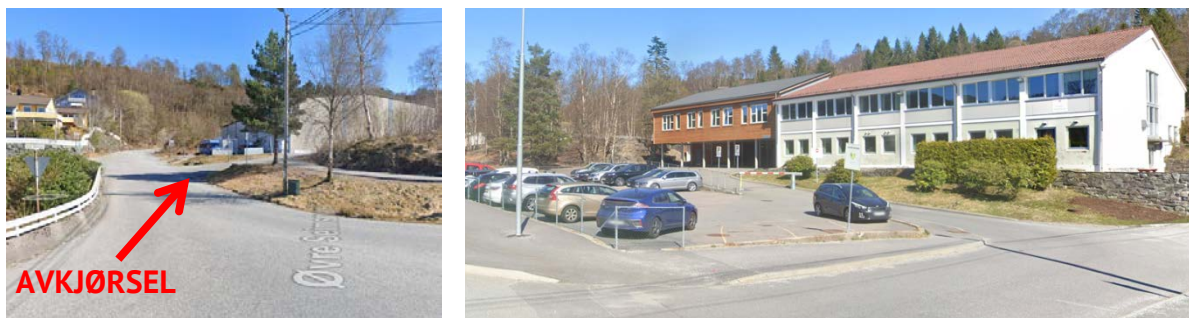
figur 35 – Avkjørsel fra Garnesvegen til Bjørnarhallen (t.v.) og avkjørsel, parkering og areal for varelevering og renovasjon for Garnes skule (t.h.) Begge bilder er tatt fra Garnesvegen.
