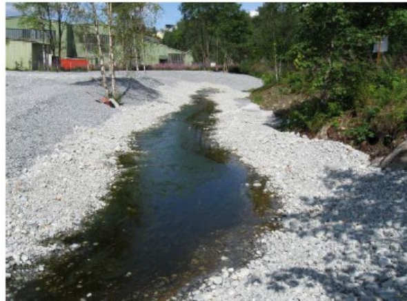
Figur 4 I den nye bekketraseen er det først lagt tett bentonittduk og deretter elvegrus. (Multiconsult 2011)
