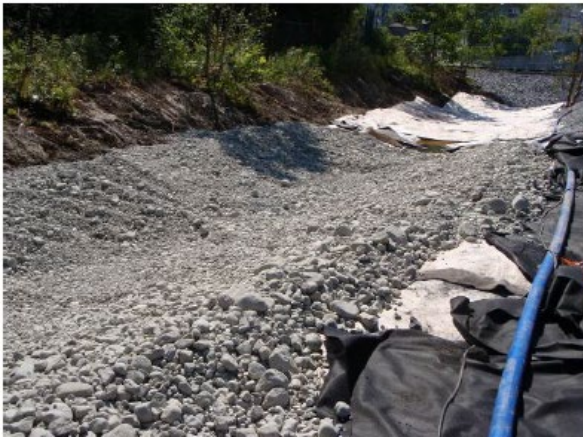
Figur 4 I den nye bekketraseen er det først lagt tett bentonittduk og deretter elvegrus. (Multiconsult 2011)
