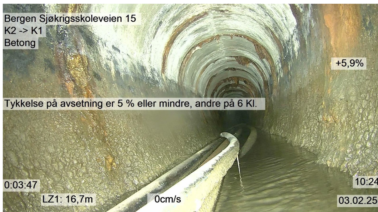
Figur 1 Kulvert under Simonsviken næringspark.
