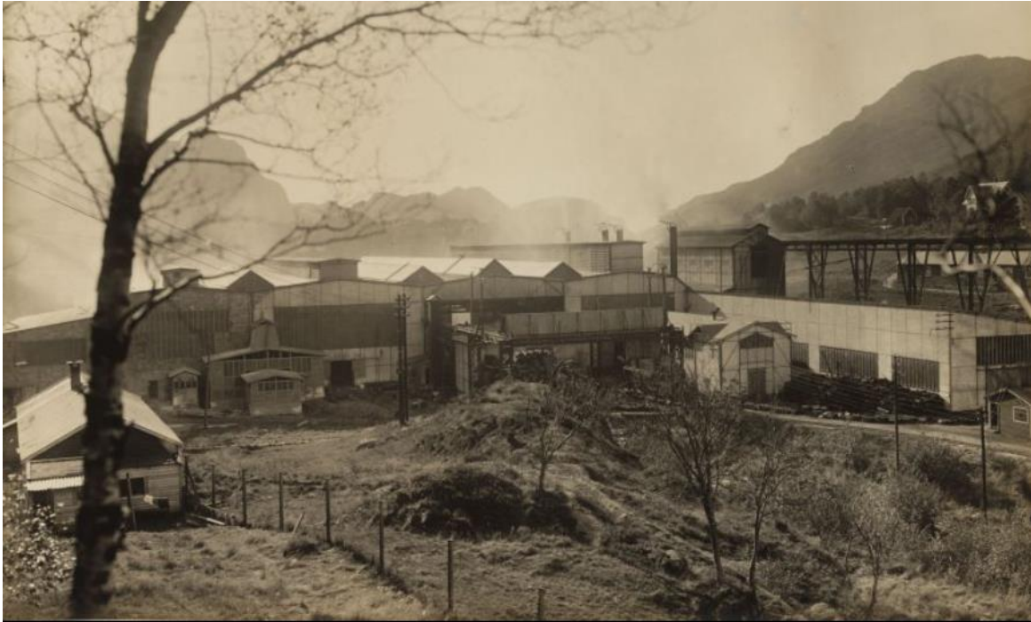
Norsk Valseverk A/S sett fra nordøst. Mellom 1917 og 1939. Kilde: UiB Marcus: ubb-bs-fol-01875-002.
