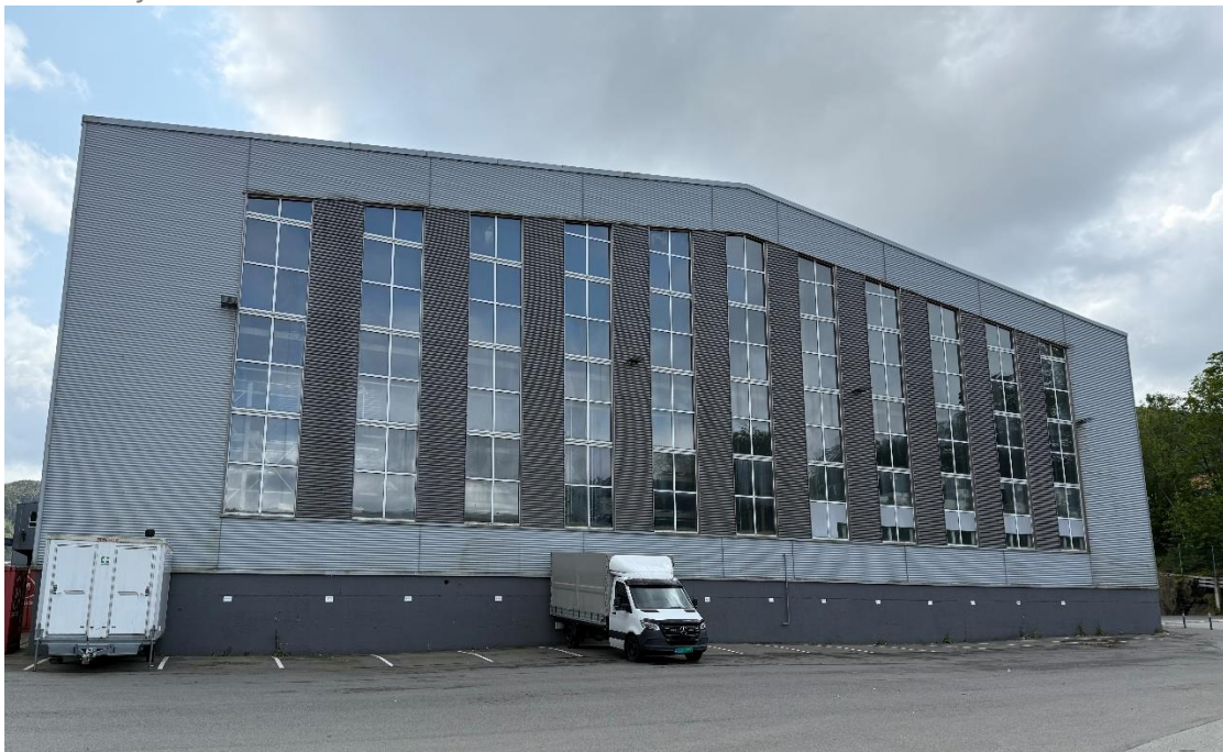
Nordfasaden på verksbygningen (Del D)
