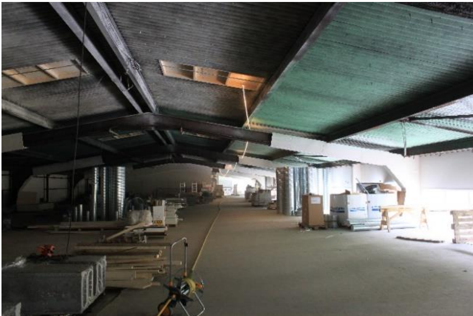
Hall C Under ombygging. Bildene er tatt i 2020.
