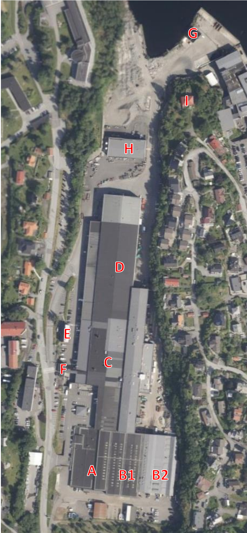
Flyfoto - Bygninger i verksområdet. Kilde: Norge i bilder
