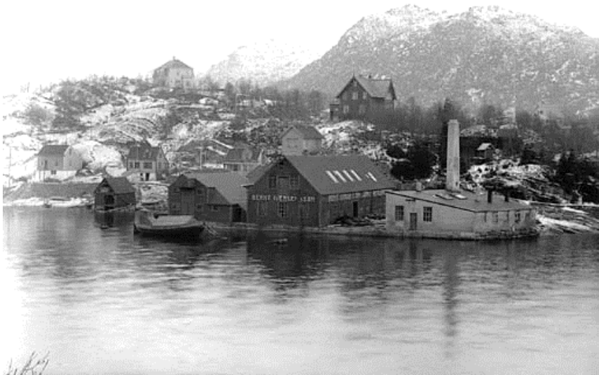
Nygårdsviken, 1918-1919, med tidligere eksisterende villa, i sveitserstil. Foto: Atelier KK, Kilde UiB Marcus, ubb-kk-n-192-009
