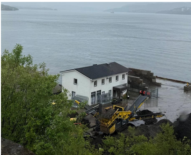
Kaibbygg med trafo.
