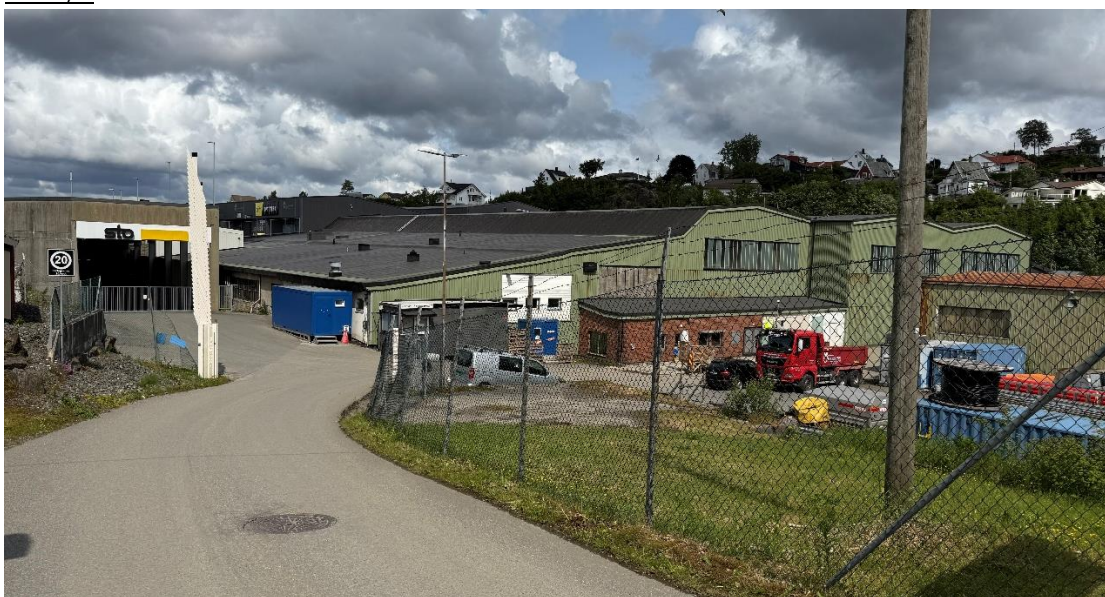
Del A og B. Fasade mot sør.
