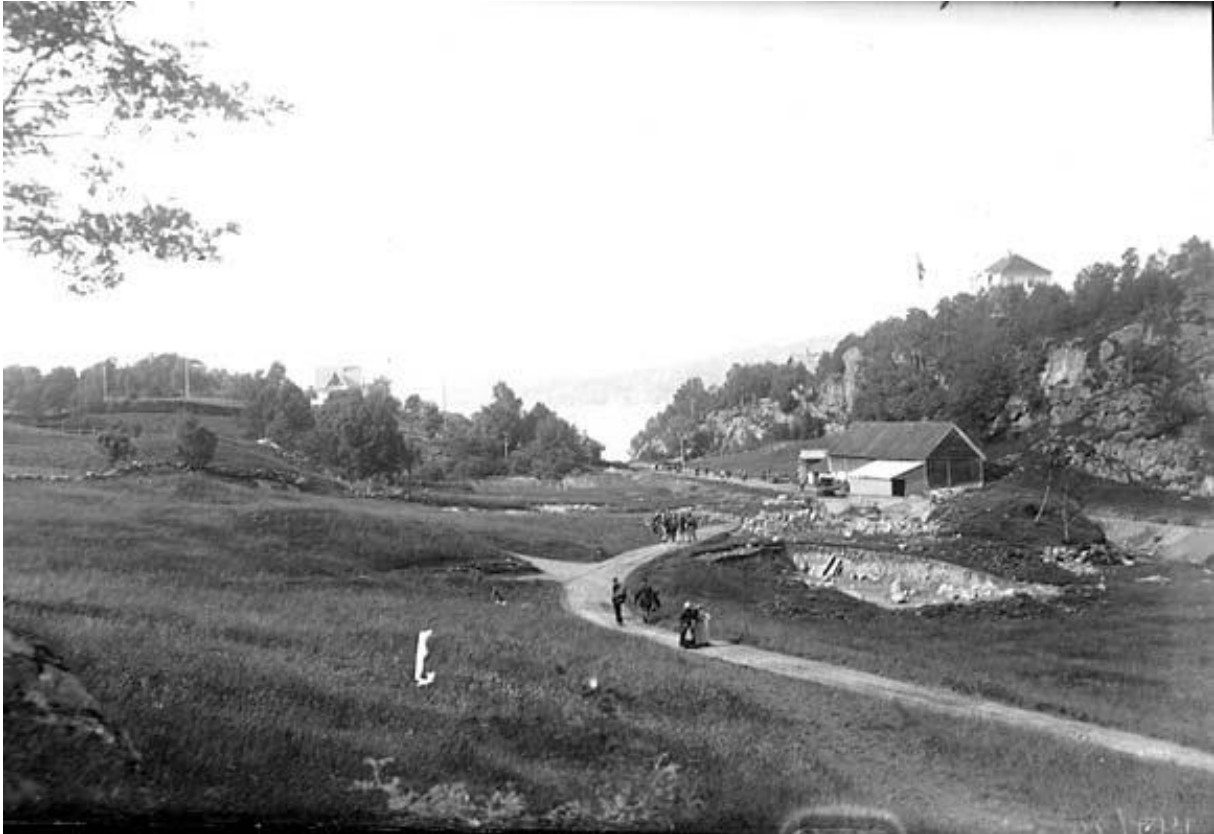
De første anleggsarbeidene i Simonsviken, sommeren 1916. Driftsbygningen på gården til høyre. Tidligere våningshus og senere anleggskontor kan skimtes i lysningen mot sjøen. Foto Atelier KK. Kilde: UIB Marcus: ubb-kk-n-147-029
