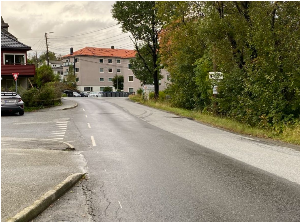
Figur 34. Langs Gravdalsveien er det i dag ensidig fortau med smal bredde (under 2,0 meter).
