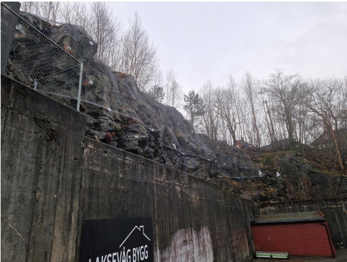
Bilde 2. Sikring av skjæring i sør. Sett mot vest
