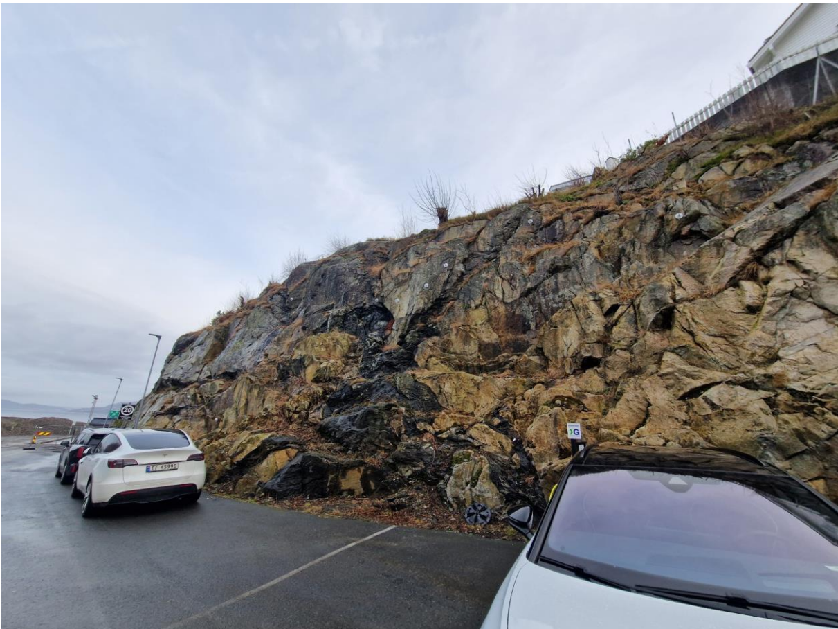
Bilde 8. Spredt bolting i skjæring i nord. Annen egenskap på berget, mer oppsprukket her. Sett mot nord.
