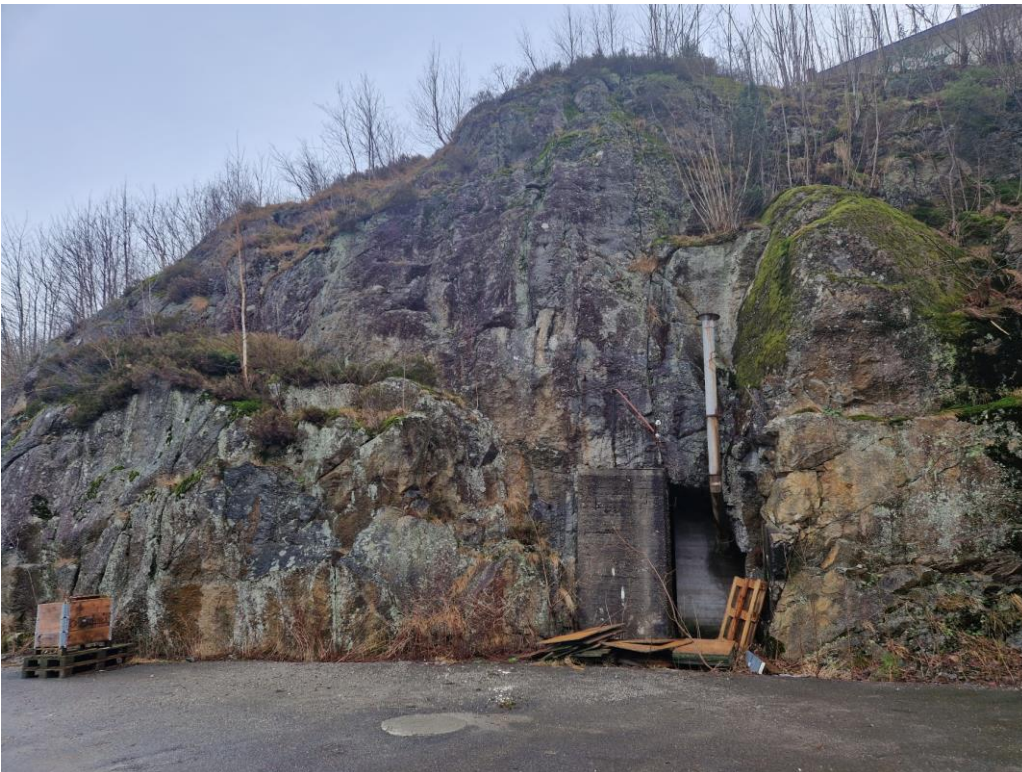
Bilde 4. Høy bergskrent med oppsprekking N340/60-80 NNØ hellende utover. Sett mot øst.
