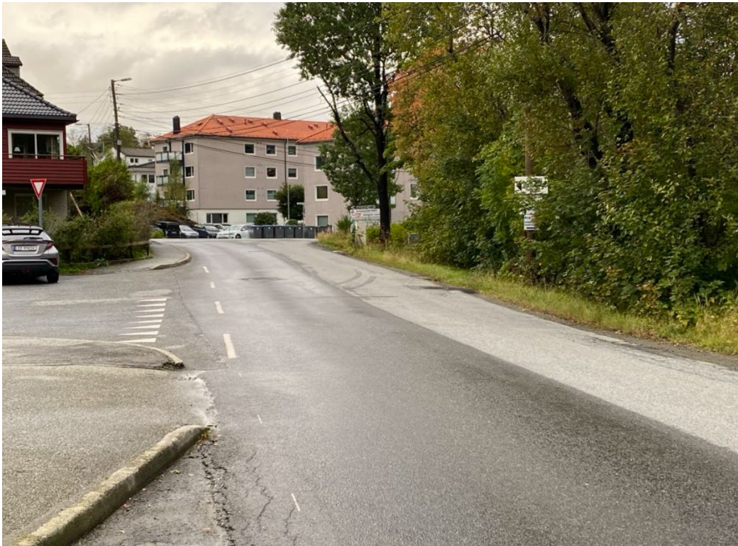
Figur 26. Langs Gravdalsveien er det i dag ensidig fortau med smal bredde (under 2,0 meter).
