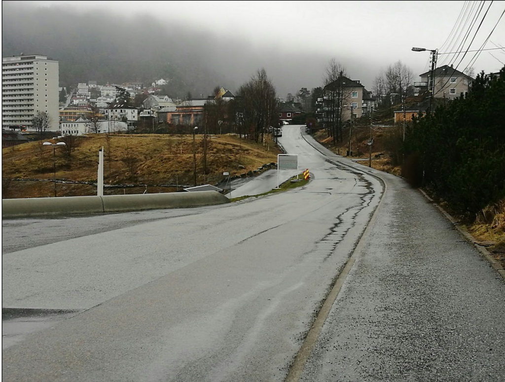
Figur 25. Sjøkrigsskoleveien frem til Simonsviken har i dag sammenhengende fortau for myke trafikanter med bredde på ca. 2,0 meter.
