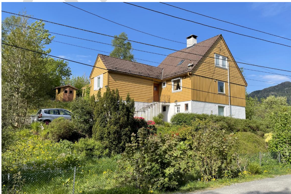
Figur 8: Eksisterende enebolig, Øvre Fantoftåsen 39, fra 1957 som skal rives.
