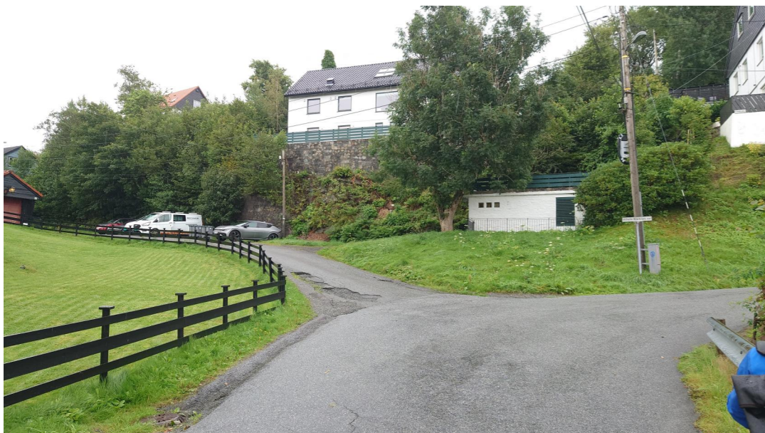
Dagens situasjon med høye terrengmurer og utflytende parkeringsareal.
