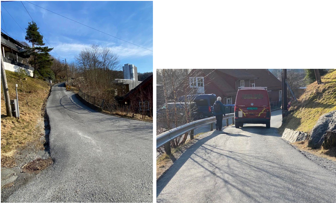
Figur 12. Gjennomgående vei (Vilhelm Bjerknes vei) til Slettebakken fungerer som en snarvei/ventil for lokaltrafikken og trafikkmengden er ca. 500 ÅDT. Gjennomkjøringen medfører ulemper for mobilitet og trafiksikkerhet/trygghetsfølelse for mange trafikanter på strekningen.
