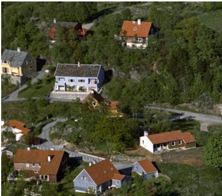
Dette flyfotoet frå 1961 gir eit godt inntrykk av korleis bygningen såg ut då den var relativt nybygd. (Foto: Widerø flyfoto, Ubb Billedsamlingen)
