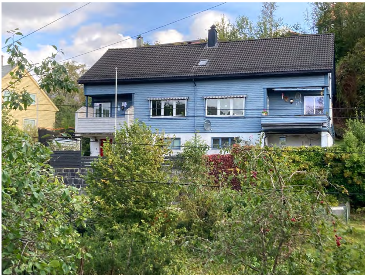
Vestfasaden av Øvre Fantoftåsen 38 syner to spegla einingar. Biletet er teke frå hagen på motsett side av vegen som ligg i søkket i terrenget mellom desse husa. Det er originale vindauge i denne fasaden.
