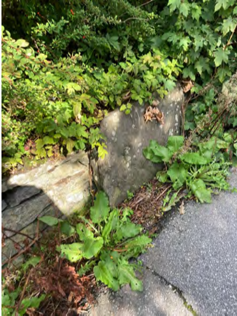
Gjengrodde, gamle murar langs vegen. Her frå mur på nordsida av vegen. Mot Øvre Fantoftåsen 45.
