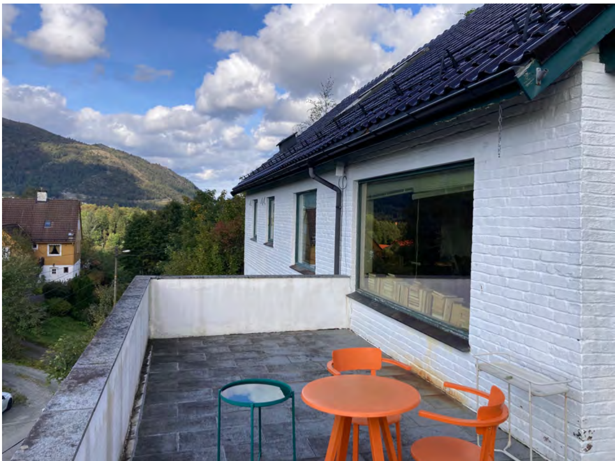
Sørvestre fasade i andre etasje. Utsyn mot Øvre Fantoftåsen 39 og på tvers av Bergensdalen til Løgstien.
