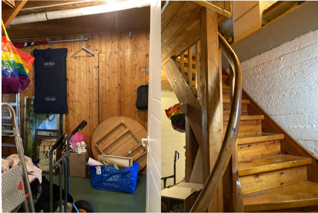
Bilete 5 og bilete 6. Kjellarrom og trappa frå kjellar og opp til første etasje.
