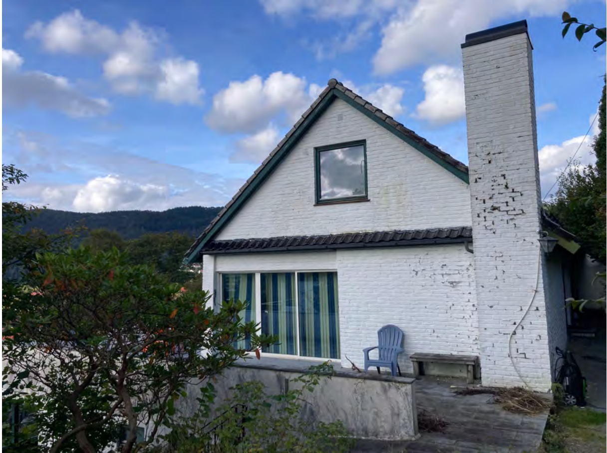
Murfasaden i Sørøst.
