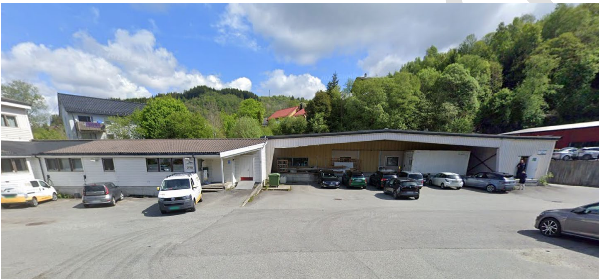
Figur 26: Næringsbygg på g/bnr. 88/84.
