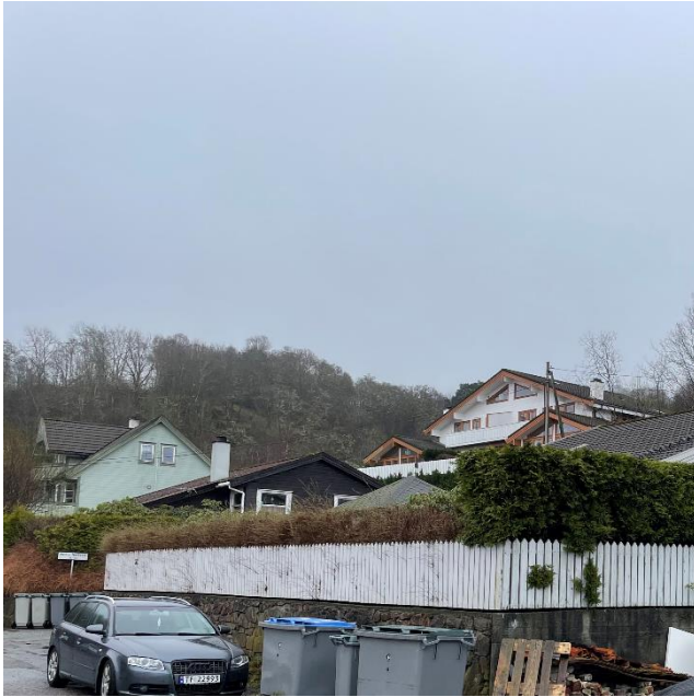
Figur 3-5: Nedre Nøttveit 36 (t.v.), 34 (midten) og 52 (t.h.)
