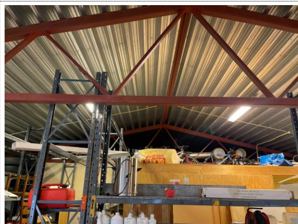
Bilde nr. 21 Takstoler
