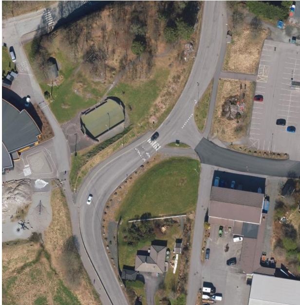
Figur 23: Flyfoto viser manglende/bortslitt oppmerking i Smøråsvegen. Kartutsnitt fra: maps.google.com
