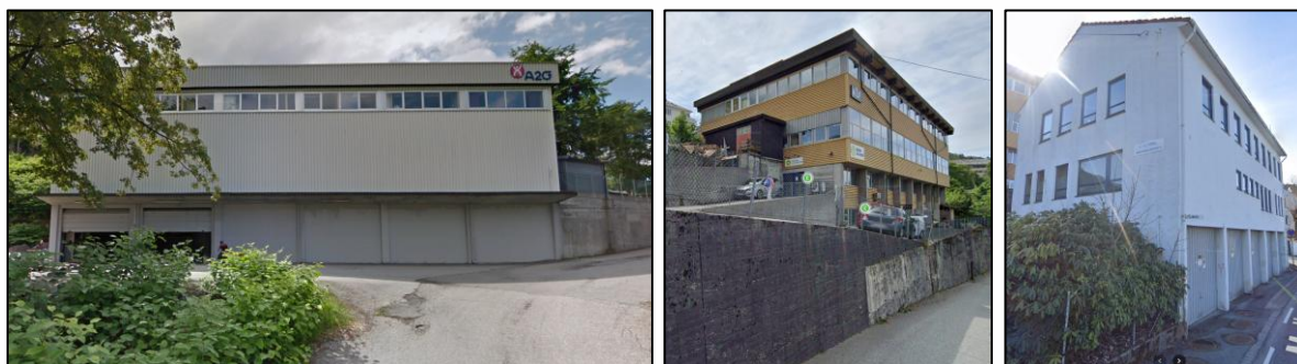
Figur 2.3.8.3 – T.v.: Klaus Hanssens vei 24. I midten: Klaus Hanssens vei 22. T.h.: Møllendalsveien 31, bygget som Helse Bergen disponerer i 2025. Bildene er hentet fra Google Street View
