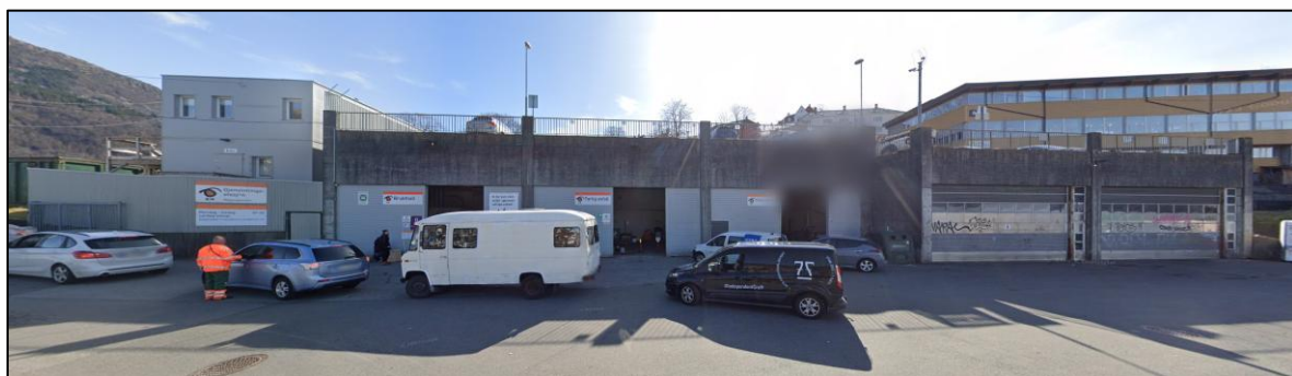
Figur 2.3.8.4 – Møllendalsveien 31, gnr. 162, bnr. 53, da området ble brukt til gjenvinningsstasjon. Bildene er hentet fra Google Street View
