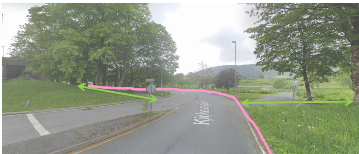
Figur 12. Kryssing over Kirkevegen ved krysset med Storetveitvegen har i dag en avstand på ca. 12 m, noe som er en uheldig avstand.
