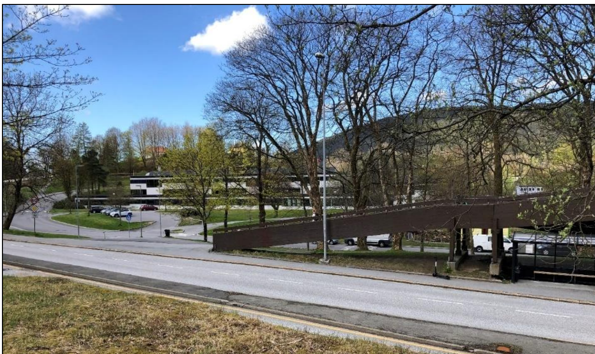
Figur 3.3.2 – Limtrebroen over Storetveitvegen. Skolen i bakgrunnen
