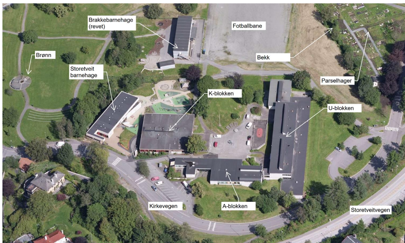
Figur 2-2 Oversikt over Storetveit ungdomsskole og Storetveit barnehage
