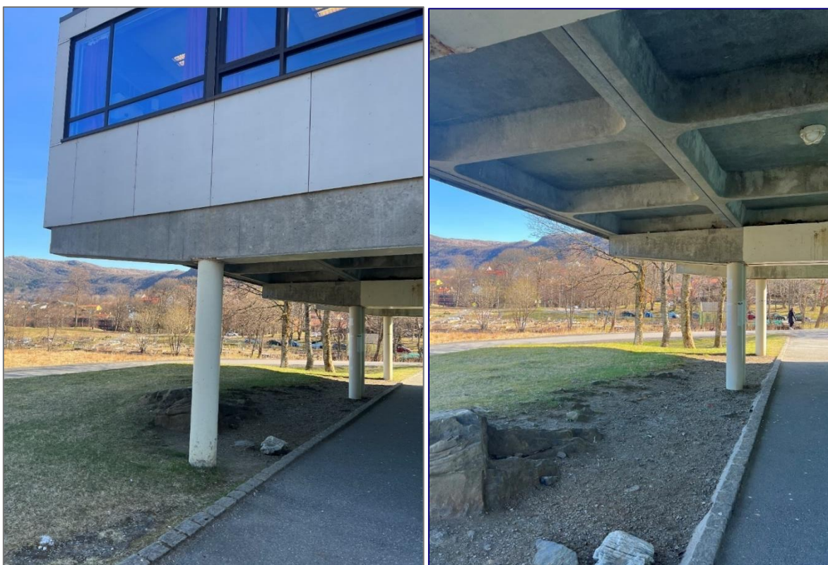
Figur 26. 1. etasje på U-blokk danner en utkraget del. Her ser man også tydelig kassetthimling, her i upusset råbetong.
