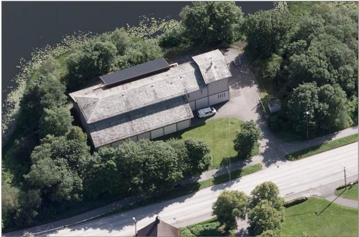
Figur 62. Skråfoto av Storetveitvegen 84 (Opplysningen 1881, 2022)
