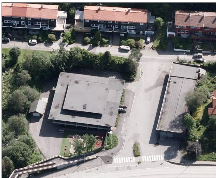
Figur 61. Skråfoto av Storetveitvegen 86 (Opplysningen 1881, 2022)
