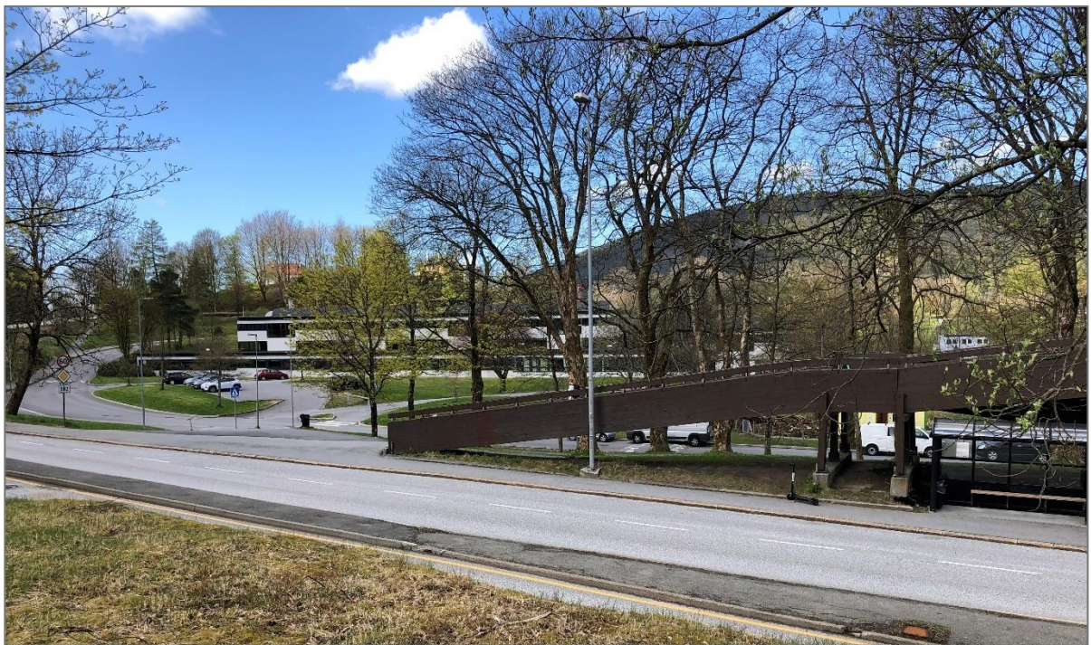
Figur 93. Limtrebroen over Storetveitvegen. Skolen i bakgrunnen.
