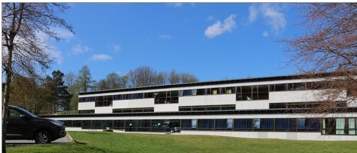
Figur 23. Fasade U-blokken sett fra øst
