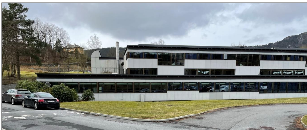
Figur 24. Fasade U-blokken sett fra øst
