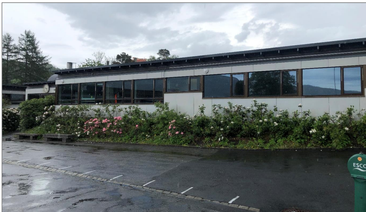
Figur 31. Fasade A-blokken, sett fra skolegård.
