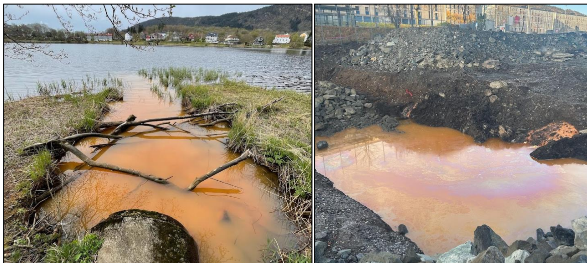
Figur 14: Uønsket hendelse i Tveitevannet (venstre) med rustfarget vann som strømmet ut av innløpet fra Slettebakken. Uønsket hendelse med antatt oljefilm i gravegrop (høyre) i tiltaksområdet.
