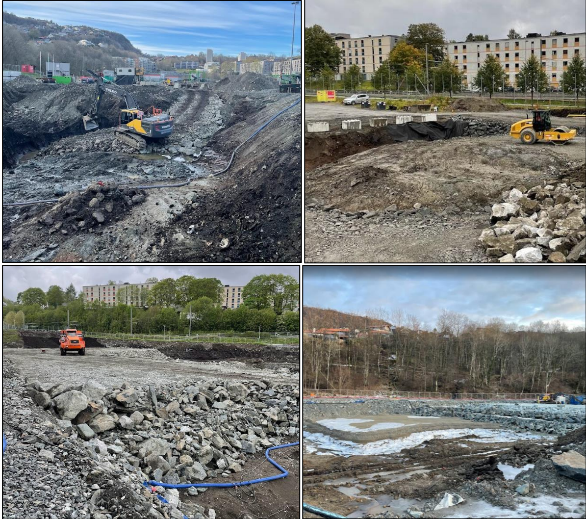
Figur 6: Bilder fra masseutskifting.
