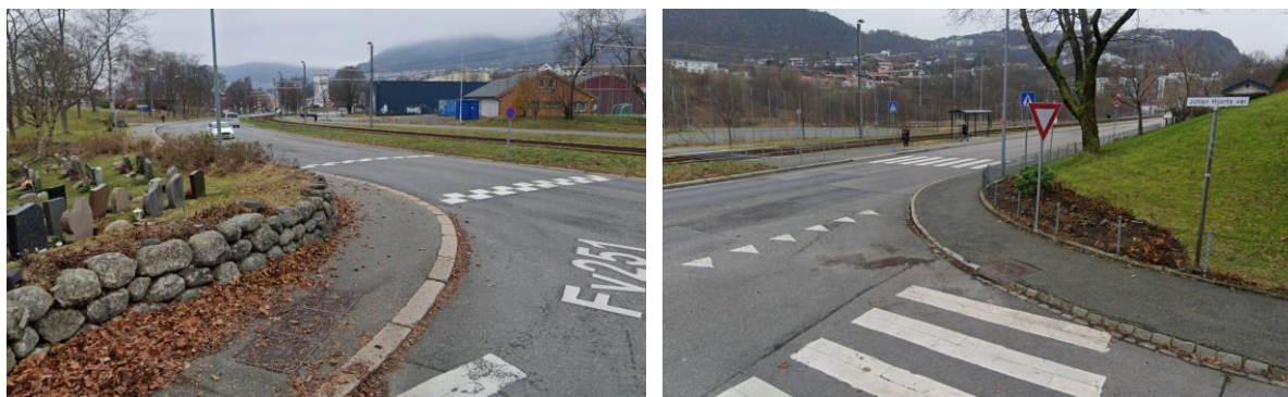
Figur 22 Sikt fra Johan Hjorts vei mot nord til venstre og mot sør til høyre. Treet mot sør befinner seg innenfor sikktrekanten og vil være et sikthinder, foto Google Maps.
