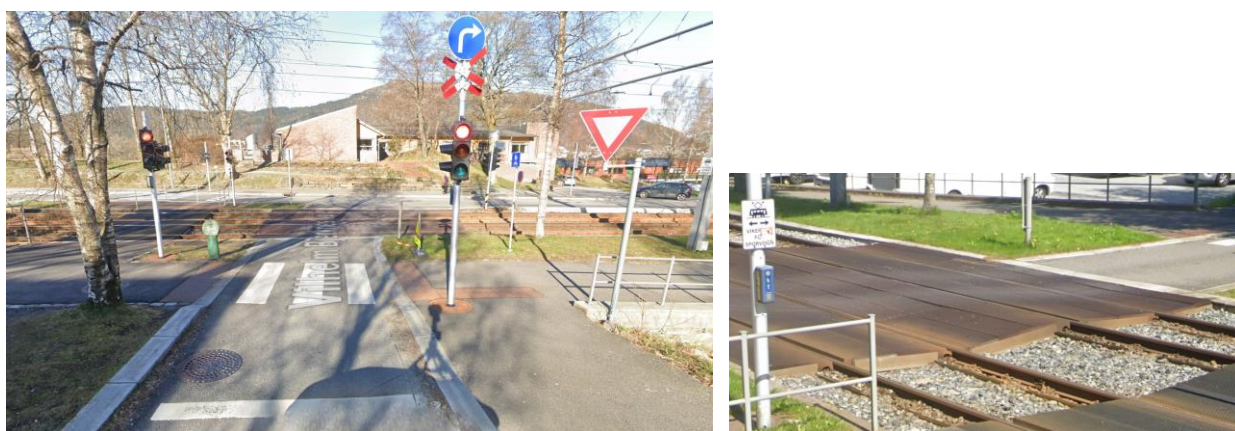
Figur 10 Krysset Bergenshallen sør sett fra sidearm, høyresving er her påbudt, foto Google Maps 2018. I utsnittet til høyre vises den vanskelige vertikale linjeføringen en får i planovergangen grunnet krav til overhøyde for spor i kurve.
