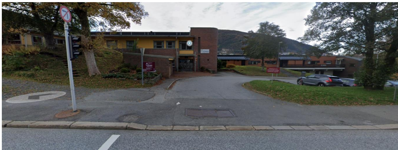
Figur 15 Avkjørsel til Slettebakken menighets eldrecenter mv, har tydelig kantstein mot vei, men manglende avgrensing mot fortau og gangareal i bakkant, foto Google Maps.
