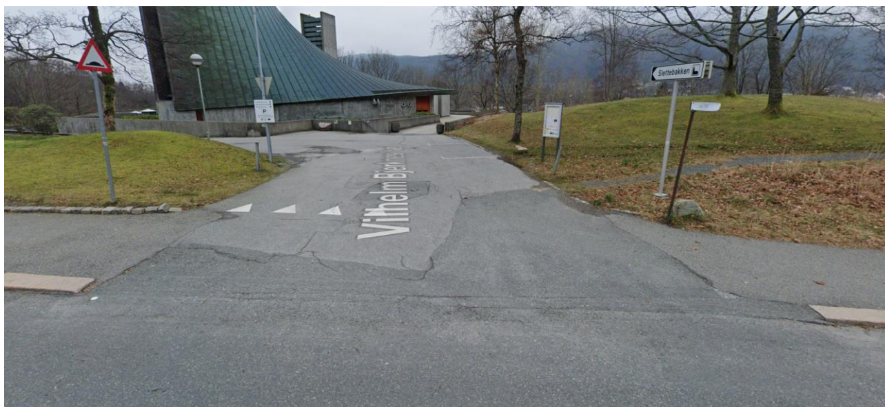
Figur 19 Avkjørsel til Slettebakken kirke mangler kantstein på begge sider av fortau, noe som medfører uklare vikepliktsforhold mellom ferdsel på fortauet og trafikk i avkjørselen, foto Google Maps.
