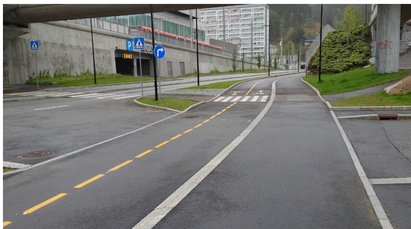
Figur 18 Eksempel på god utforming av avkjørsel som krysser sykkelvei og fortau hentet fra SVVs veileder V320 Planlegging og oppsetting av trafikkskilt.
