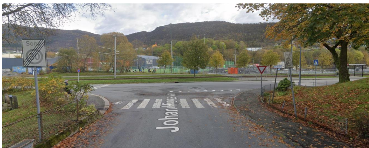
Figur 21 Krysset Vilhelm Bjerknes' vei – Johan Hjorts vei sett fra tilfartene, foto Google Maps.
