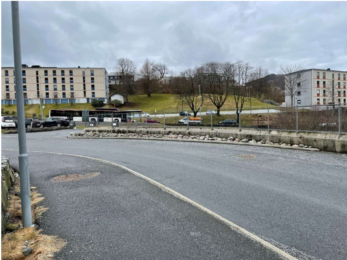
Figur 2-5 Oppstrøms Fysak, mur som hindrer flomvannet, bilde i retning mot vest
