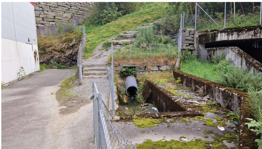
Figur 3-6 Eksisterende utløp ved Fysak.
