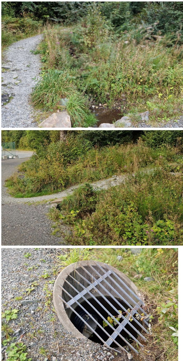
Figur 4-3 Bilder av bekk, kryss med sti og inntak av sideløp på punkt 4.
