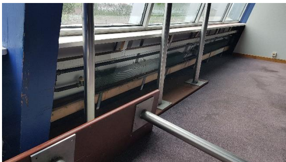
Bilde nr. 5 – Eternit på innsiden av yttervegg, bak radiatorer mm.
