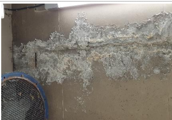
Bilde nr. 251.6 Avflassing av betong i tak. Viser synlig armering
