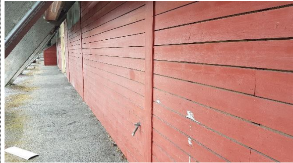
Bilde nr. 2 – Eksteriør mot vest, internit bak spaltepanel i 1. etasje.
