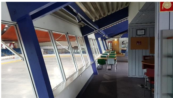
Bilde nr. 11 – Eternit over og under vinduer i kafeareal, på vegg mot hall.
