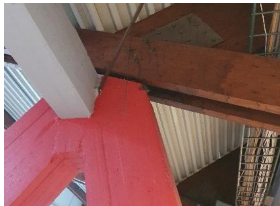
Bilde nr. 223.1 Betong og limtrebjelker.
