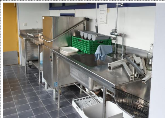
Bilde nr. 273.2 Kjøkkeninnredning i cafedelen
