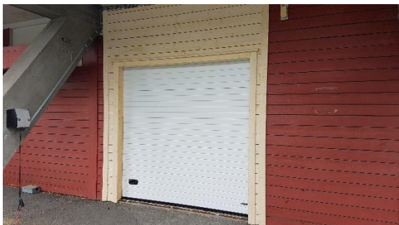
Bilde nr. 17 – Noen plater er sanert i forbindelse med utskifting av port på vestsiden.
