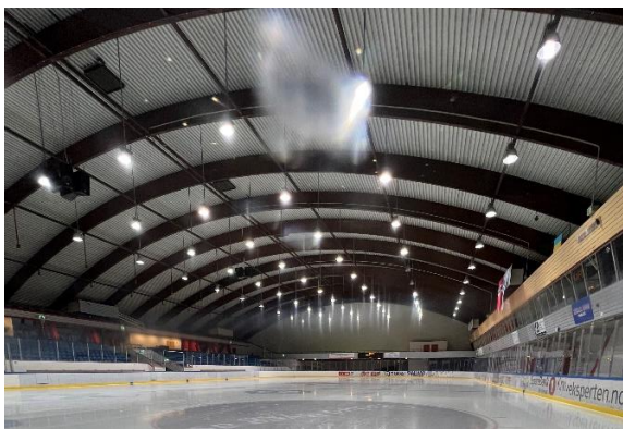
Bilde nr. 221.1 Bæresystem i tak av limetrekonstruksjoner.
