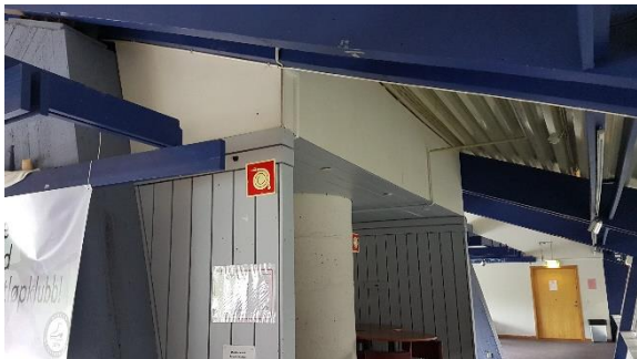
Bilde nr. 9 – Internitplater bak spaltepanel ved toalett-/garderobeseksjoner i kafeareal. Antatt eternit videre opp mot tak (hvitmalt).
