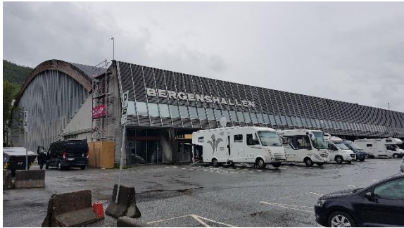
Bilde nr. 1 – Eksteriør mot vest. Antatt internit bak trepanel over og under vinduer.
