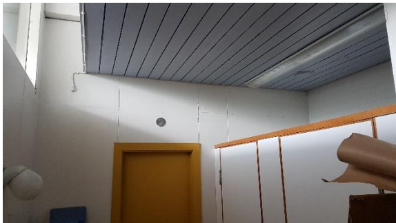
Bilde nr. 15 – Toalett ved ny port på vestsiden. Internit i himling, eternit på vegger. Tilsvarende i publikumstoalett ved søndre trappehus.
