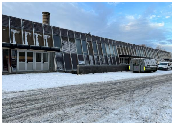
Bilde nr. 2.03 Fasade mot øst.
