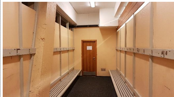
Bilde nr. 6 – Eternitplater mellom garderober, satt i spor i trestolper.
