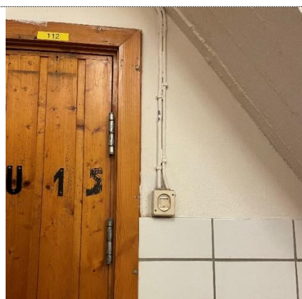
Bilde nr. 433.10 Installasjon garderobe
