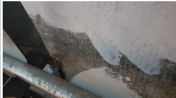
Bilde nr. 4 – Eternit på innsiden av yttervegg mot vest, hjørnerom i nord.
