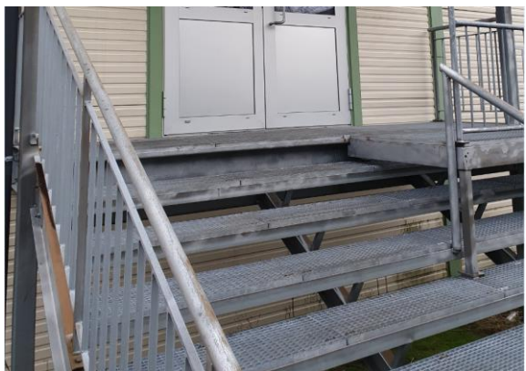
Bilde nr. 722.2 Ståltrapper og ramper på sørsiden er i god stand. Bør overflatebehandles
