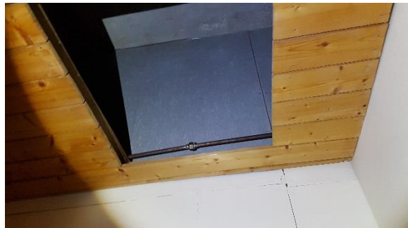
Bilde nr. 16 – Lagerareal, 1. etasje vest. Internit i himling, eternit på vegg.
