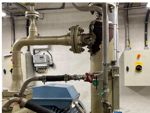
Bilde nr. 350.01 Synlig korrosjon på kjølerør tilknyttet kjølekompressor.
