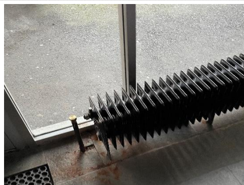
Bilde nr. 320.01 Radiatorer koblet fra varmekrets pga. lekkasje.
