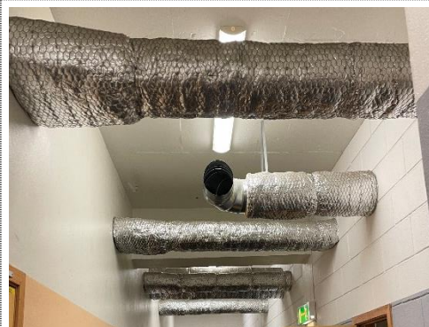
Bilde nr.360.02 Åpen kanal i korridor ved garderober i Ishallen.
