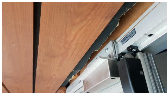
Bilde nr. 18 – Internitplater over himling ved innganger til kafe i 2. etasje.
