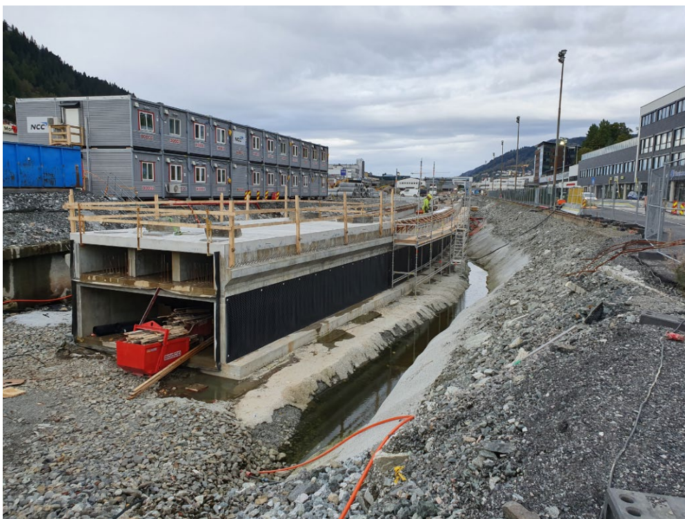
Figur 3-3: På Mindemyren er det gjennomført bekkeåpning med et to-etajers system, med flomkulvert i nedre løp og åpent vannspeil i øvre del.
