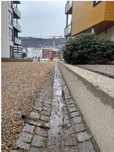
Figur 2-1: Eksempel på overvannsrenner som føres direkte til sjø, uten fordrøyning. Fra venstre: Damsgård, Nøstet, og Solheimsviken. Alle foto: Even Greve Økland
