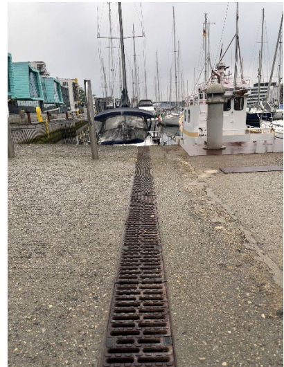
Figur 2-1: Eksempel på overvannsrenner som føres direkte til sjø, uten fordrøyning. Fra venstre: Damsgård, Nøstet, og Solheimsviken. Alle foto: Even Greve Økland
