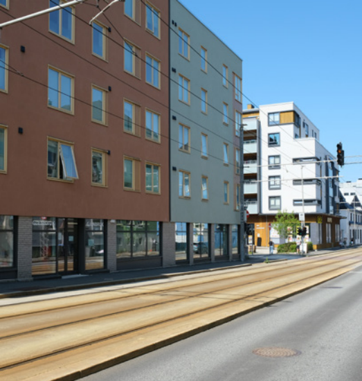
Foto: Bygninger i Kronstadtparken med næring i første etasje og boliger over.
