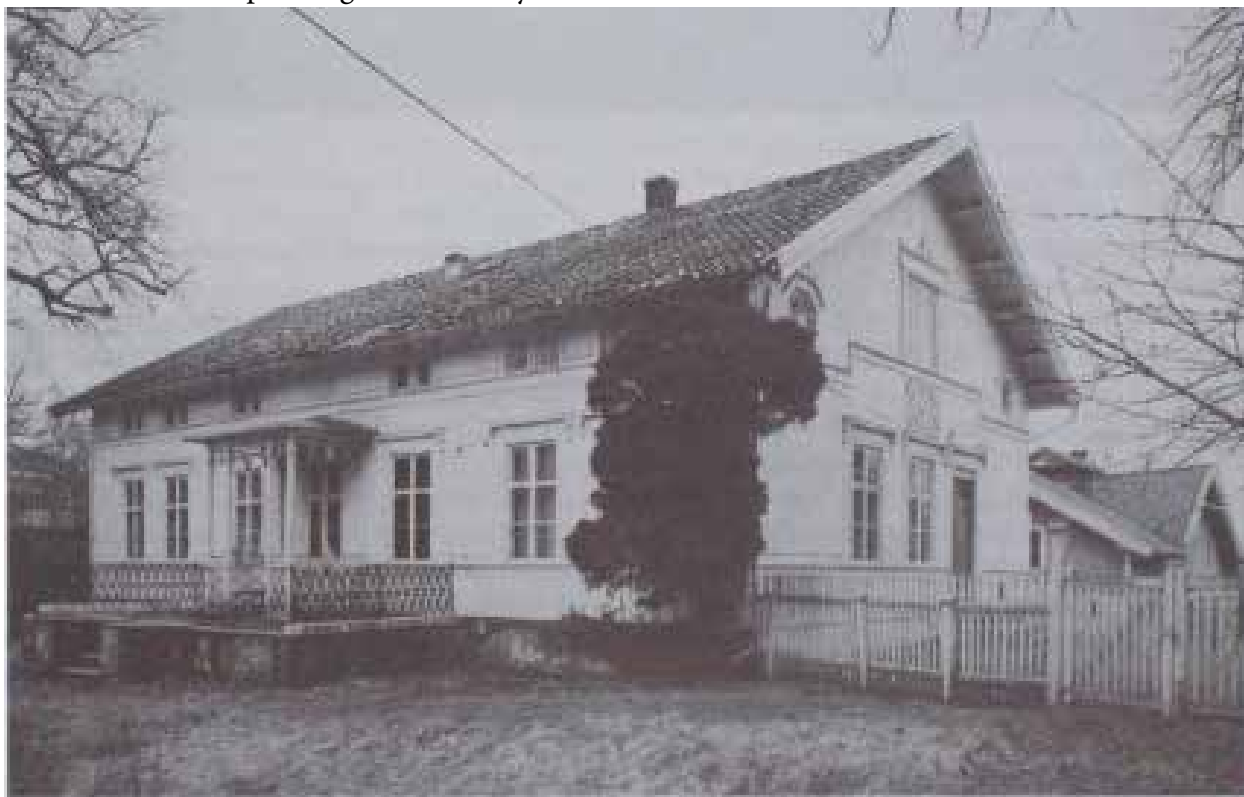
Fig. 16: Den lange fasaden i nord og kortveggen i vest er dei mest forseggjorte på våningshuset. Med ståande panel og dekor i sveitsarstil. Verandaen sentrert i nordfasaden er skildra i branntaksten. Bilete over er frå 1973, då det var mindre vegetasjon i den nære hagen. Foto Ø.H. Berger. Bilete er henta frå En storyby i miniatyr: Bergens bygningsverden 1850-1916: artikler om arkitektur.
