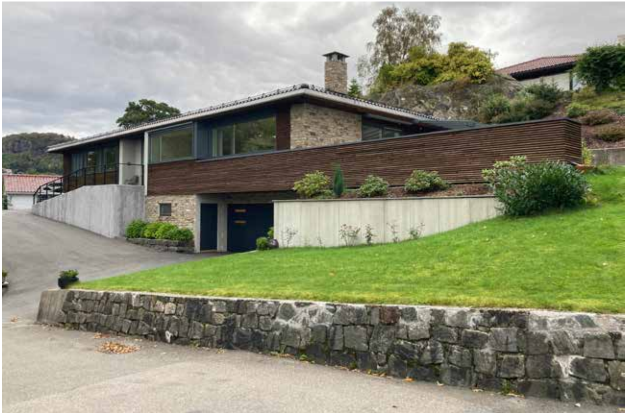
Fig. 38: Haakon Sæthres veg 2 med byggeår 2016, ligg rett vest for det planlagde tiltaket. For å sjå korleis tilkomst og planlagd byggehøgde samspekar med denne villaen, sjå fotomontasje i Fig. -, s.
