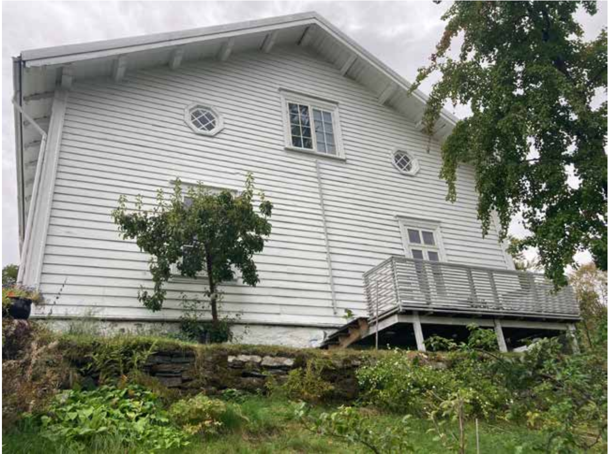
Fig. 47: Austfasaden. HER er det liggande panel og fasaden er mindre forseggjort enn den i vest. Legg merke til muren i forgrunnen.
