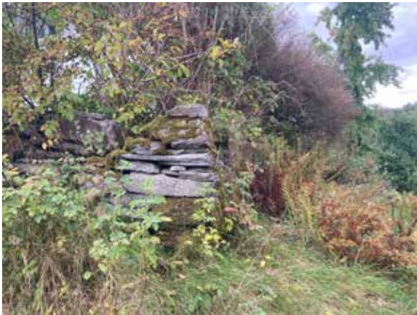
Fig. 48: Mur søraust for våningshuset.
