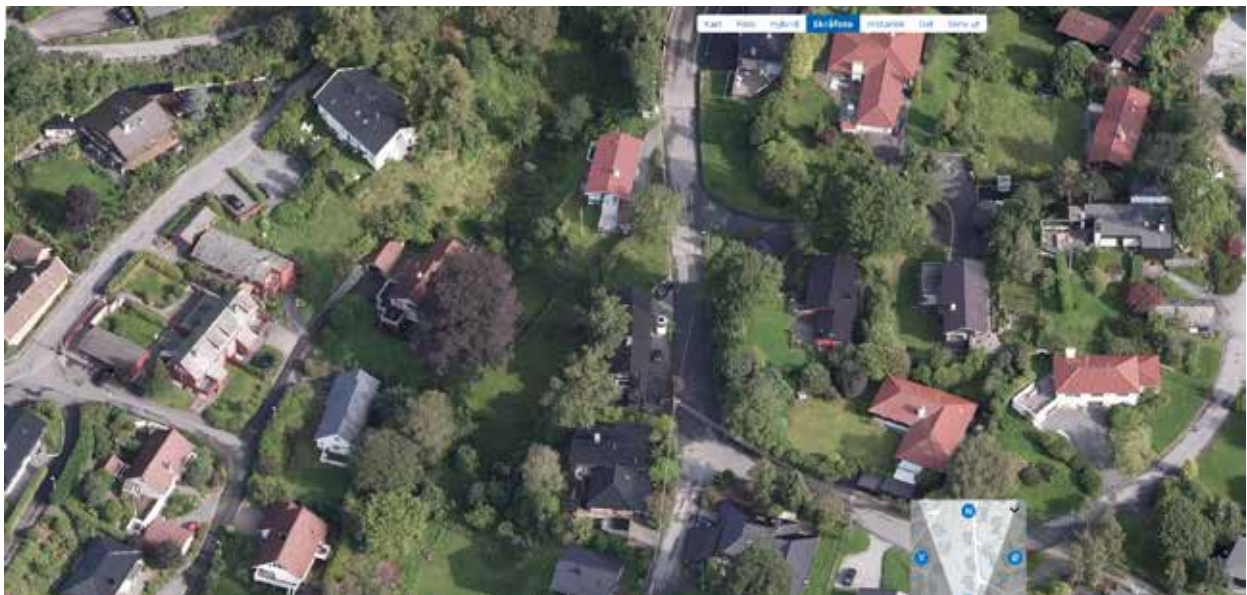
Fig. 27: Dette skråfotoet gir eit godt bilete av bygningsmiljøet i og nært planområdet. Villabusetnaden omkransar planområdet med unntak av i nordaust. Nede til venstre i bilete ligg det opphævelege tunet. Henta frå kart.1881.no. (tidsetjinga av bilete er ikkje oppgitt, men vi ser at Haakon Sæthres veg 2 frå 2016 iallfall er med i bilete.
