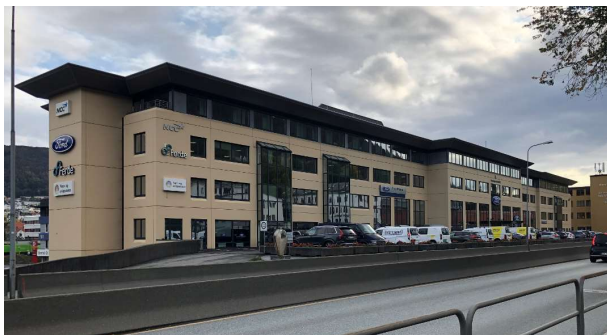
3-5 Fjøsangerveien 68 sett mot sørøst.
