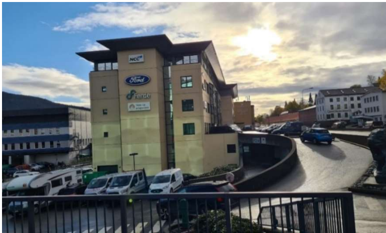
5-23 Eksisterende bygg i felt KBA5 sett mot sør.
