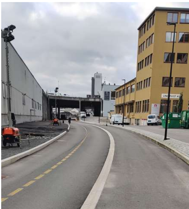
3-13 Det tidligere jernbanesporet går tvers gjennom planområdet, og er bygd ut til sykkelveg. Foto: Multiconsult
