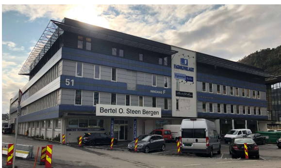
3-7 Kanalveien 51 sett mot sør.
