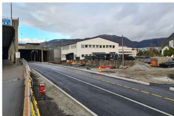
3-10 Sykkelvegen sett mot nordøst. Kanalveien 53 midt i bildet.
