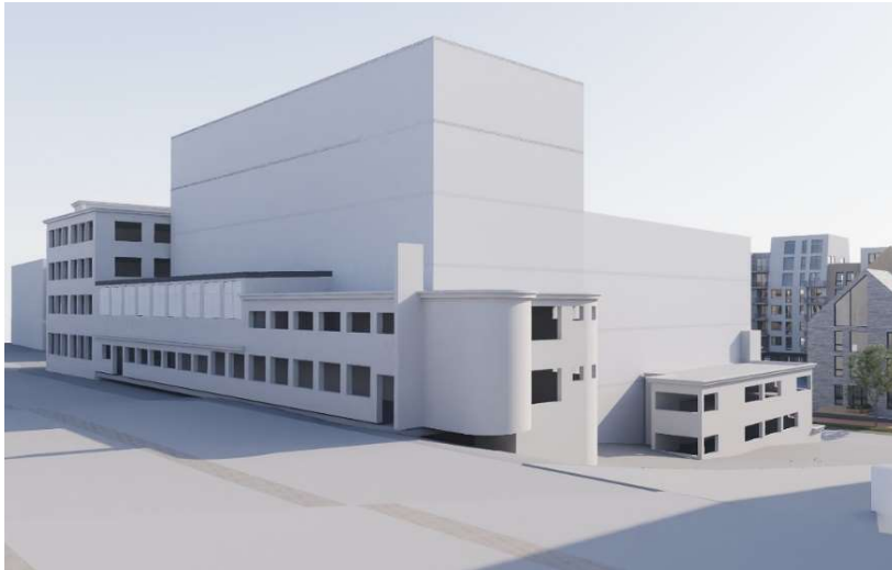
5-25 Kontor- og næringsbygg i felt KBA6 sett mot nordøst. Ill: Link Arkitektur AS
