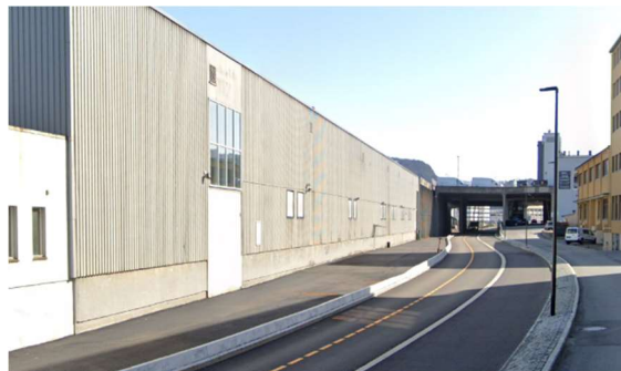
3-6 Sykkelvegen sett fra nord. Fjøsangerveien 68 til venstre og Kanalveien 51 til høyre.
