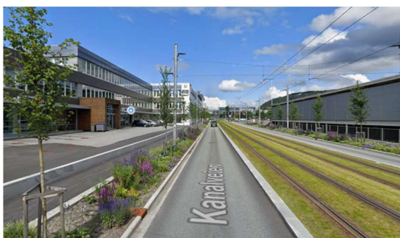
3-21 Kanalveien sett mot nord, med bybanetraséen som er etablert for linje 2.
