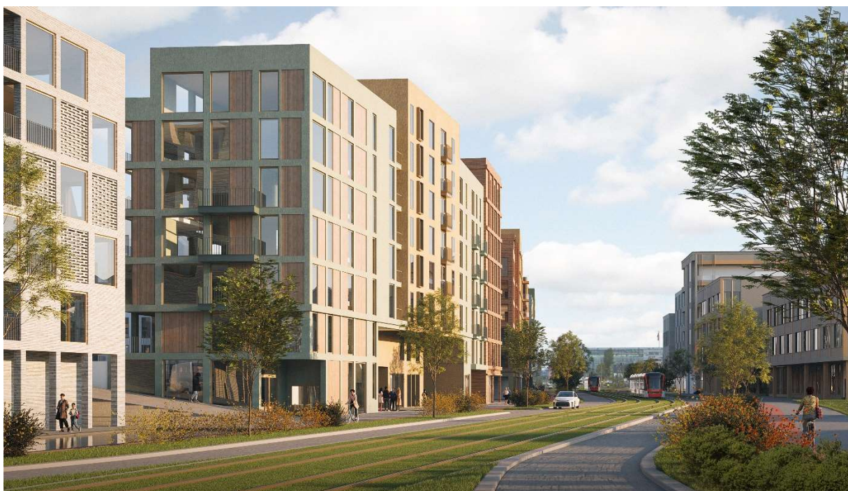
5-20 Boligkvartal 3 (KBA1-KBA3) sett fra Kanalveien mot nord. Link Arkitektur AS
