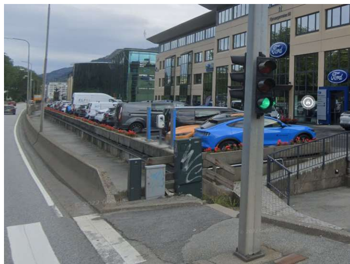
5-83 Flere strømskap er plassert midt i fortauet nord for dagens bussholdeplass og hindrer passasje Foto: Google maps.
