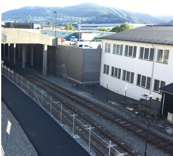
Figur 3-35 Kanalveien 53 ligger tett inntil jernbanetraséen og rampen.
