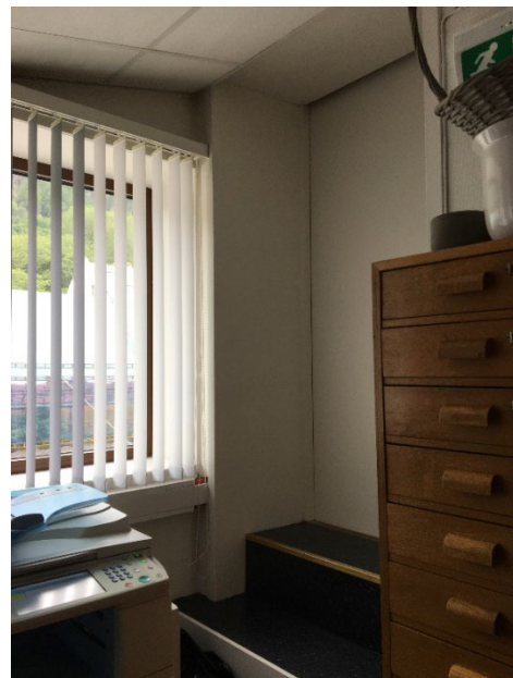
Figur 3-9 Tydelig påbygg med nivåforskjell mellom en eldre og en nyere del.
