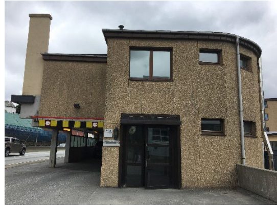
Figur 3-5 Fasaden mot sør er del av det opprinnelige vestre Grungbygget. Bygget er seinere påbygd i høyden, fasaden mot sørvest er åpnet og det runde hjørnet mot sørøst er endret. Hele fasaden er kledd med plater.
