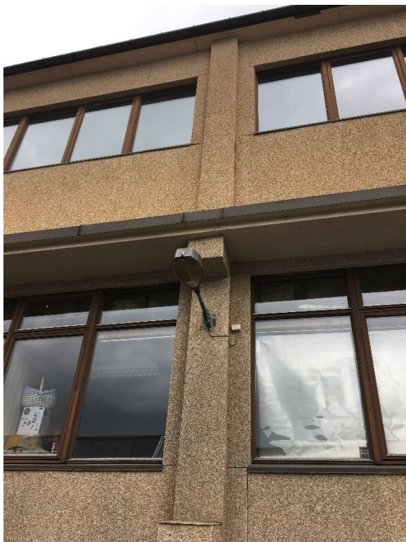
Figur 3-12 Fasaden på den østre delen er kledd med plater, men det er fortsatt mulig å se de opprinnelige detaljene, som disse profilene.
