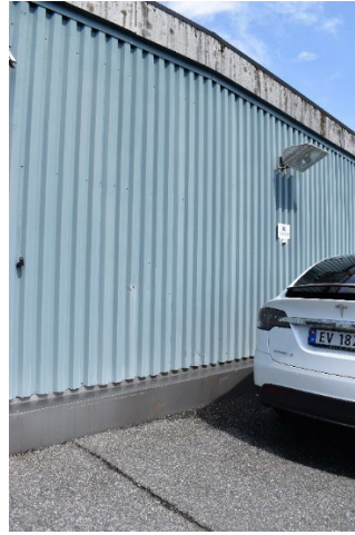
Figur 3-26 Deler av bygget er kledd med blikk.
