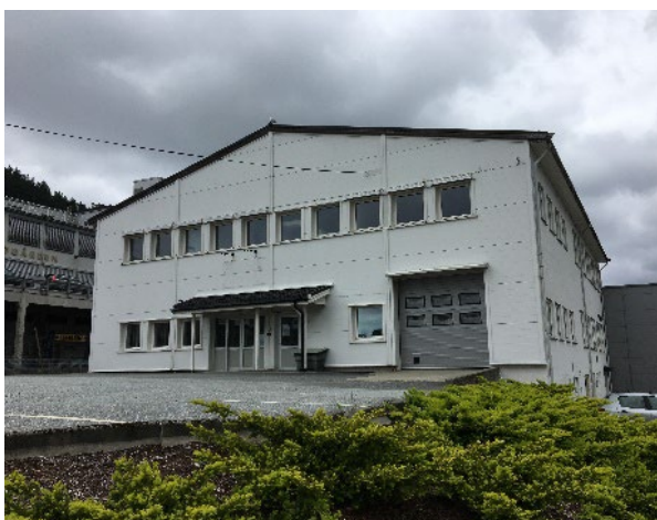
Figur 3-34 Fasade mot sør.
