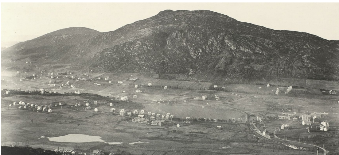
Figur 2-1 Mindemyren tidlig på 1900-tallet. Solheimsvannet ligger til venstre i bildet, repslagerbanen er på plass. Kilde: Bergen byarkiv.
