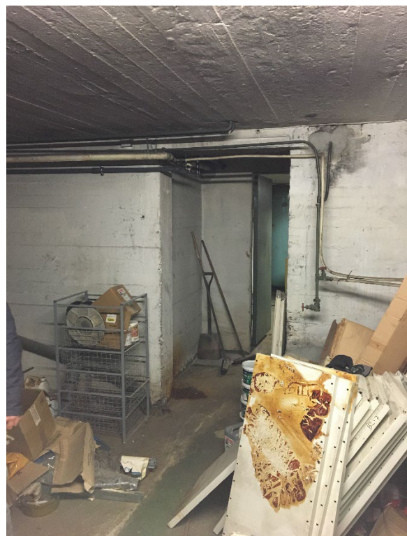
Figur 3-13 Kjelleren med fyrrom i det østre Grung-bygget er intakt.
