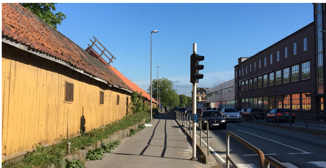
Figur 2-2 Den fredete repslagerbanen på vestsiden av Frydenbøggården (Minde allé 35)
