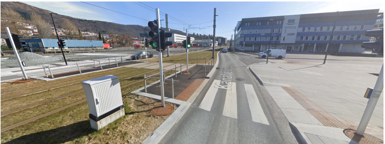
Figur 2-1 Den nordligste kryssingen i Kanalveien har saksede signalfelt. Hentet fra Google Maps Street View.
