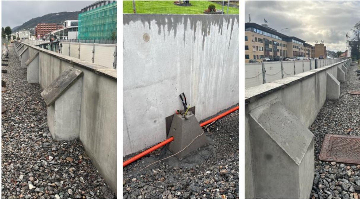
Mur sør om midtre portal med skifer på topp mur og ca halvparten av pilastrene har skifer. Viser også et lysmastfundament med trekkerør og jording.
