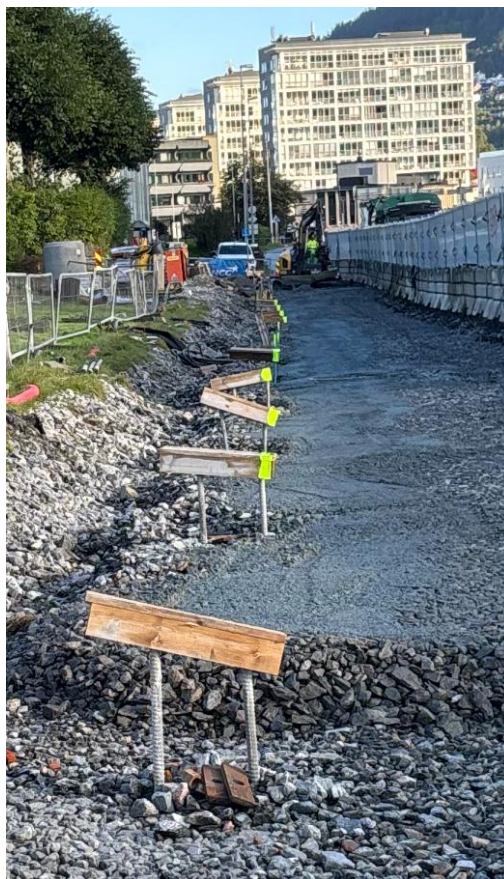
Micropeler, som er fundamentert 1,5 m i fjell
