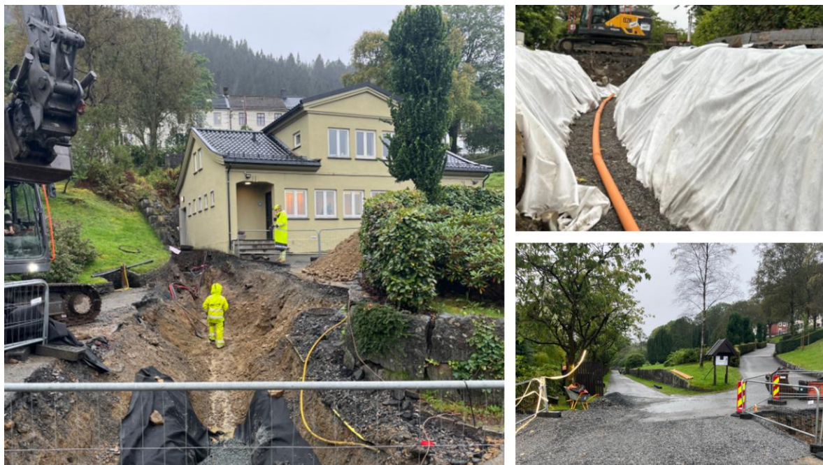
Arbeider ved driftsbygget
