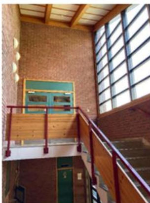
Figur 6: Vindu i trapperom (Foto: Byantikvaren 2020)
