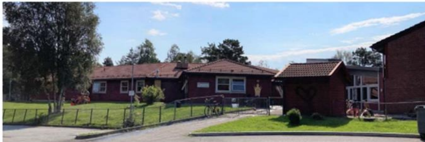
Figur 9: Haugatun Barnehage ble oppført i 1990, og i 2006 fikk anlegget et påbygg som koblet barnehagen med Vadmyrveien 77. (Foto: Byantikvaren, 2020)
