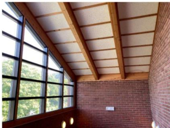
Figur 7: Innvendige teglvegger og eksponerte limtresperrer i taket. (Foto: Byantikvaren 2020)
