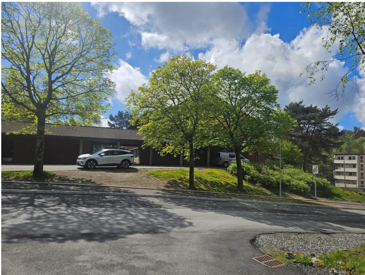
Figur 5-5. Dagens bygg helt i vest, med Vadmyrsveien i front. Bildet er tatt mot sør. Foto: Multiconsult, 2026
