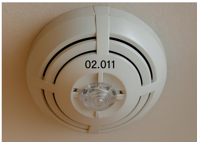
Fysisk merking av detektor på sløyfe 02, detektornummer 011
