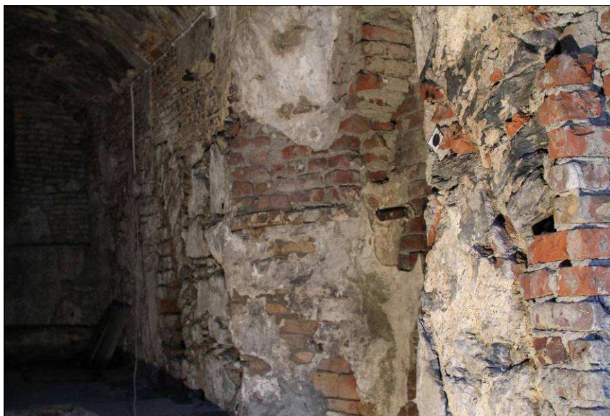
Fig 58. Det er brukt mye teglstein ved de ulike ombyggingene av M12. Stedvis er teglen løs og i dårlig forfatning (foto: Byantikvaren 2009).
