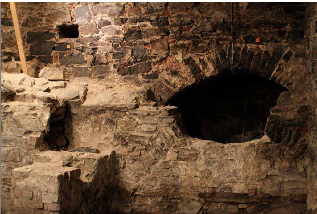
Fig 26. M23 med rundbuede gjennomganger. Muren er ikke en del av middelaldermurverket men er satt opp i forbindelse med tårnfoten i det første kirkebygget (foto: Byantikvaren 2009).
