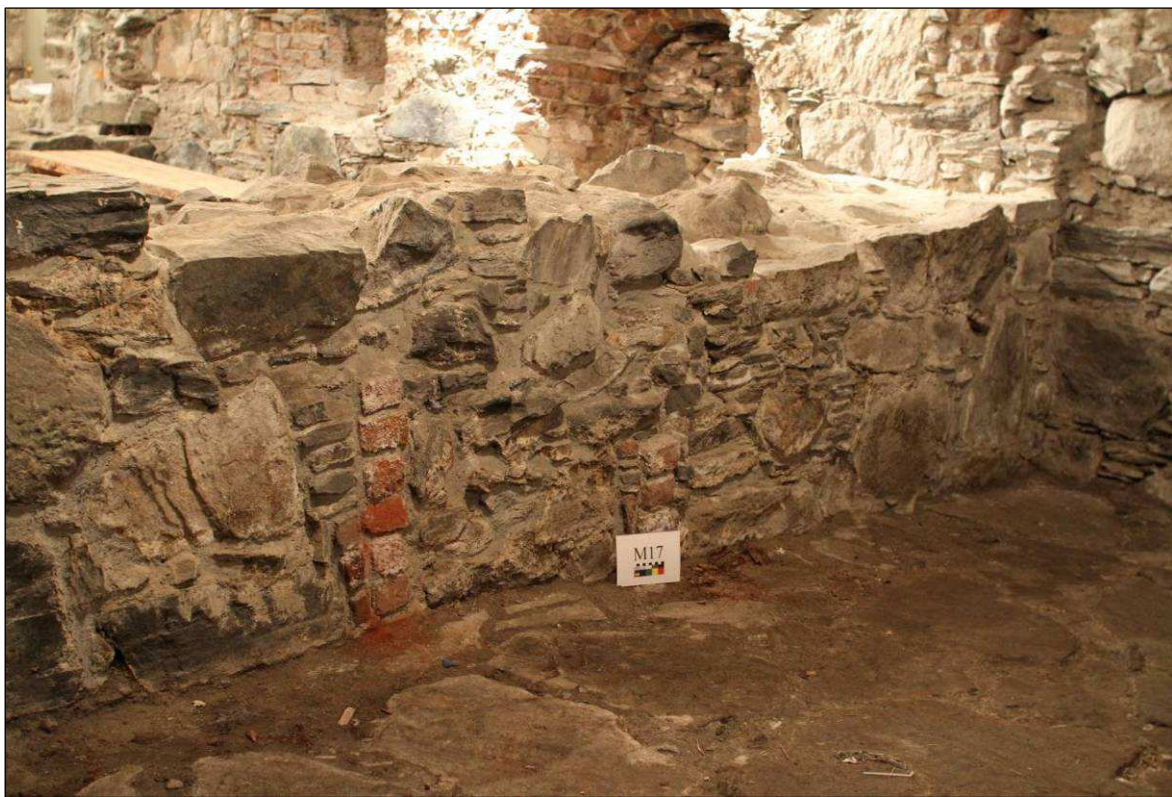
Fig 33. Østlig del av søndre murliv i M17. Merk teglsteinen midt i bildet som stammer fra en gjenmurt portal i skilleveggen (foto: Byantikvaren 2009).
