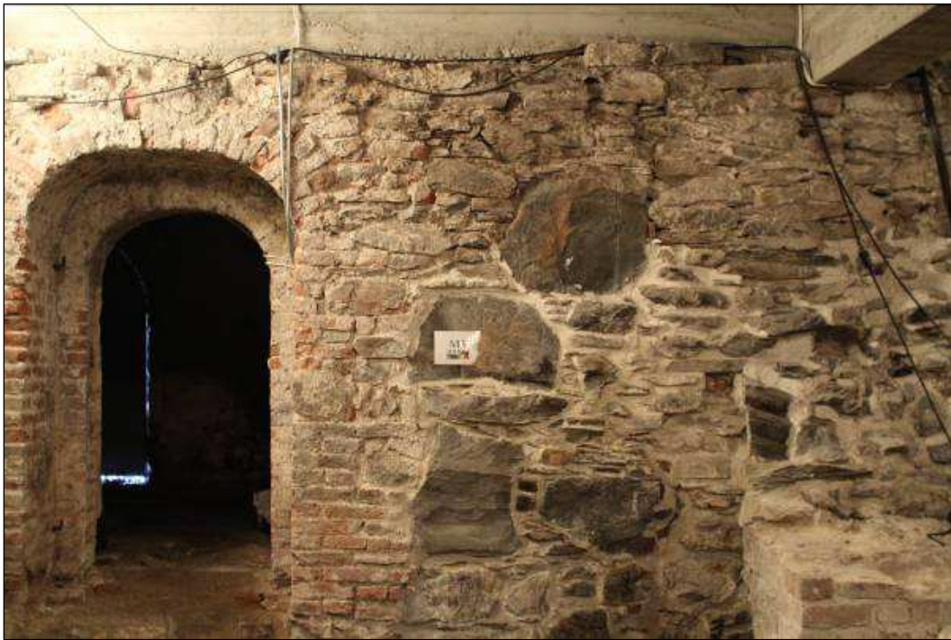
Fig 21. Nordlig del av innerlivet i M3 med den yngste portalen i veggen (Å28). Den teglforete portalen er ikke middelaldersk. Portalen fører til en av gravkjellerne på østsiden av kirken (foto: Byantikvaren 2009).
