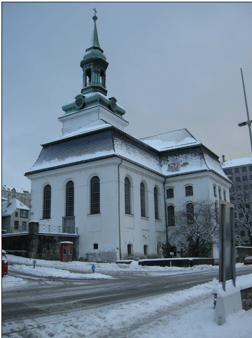
Fig 1. Nykirken på Nordnes slik den framstår i dag. Deler av murverket fra Erkebispegården er eksponert i terrassen bak telefonkiosken (foto: Byantikvaren 2009).
