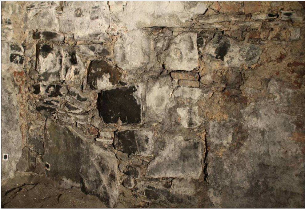
Fig 55. I rom 9 er det i sørlig murliv av M11 eksponert et parti med middelaldersk murverk (foto: Byantikvaren 2009).
