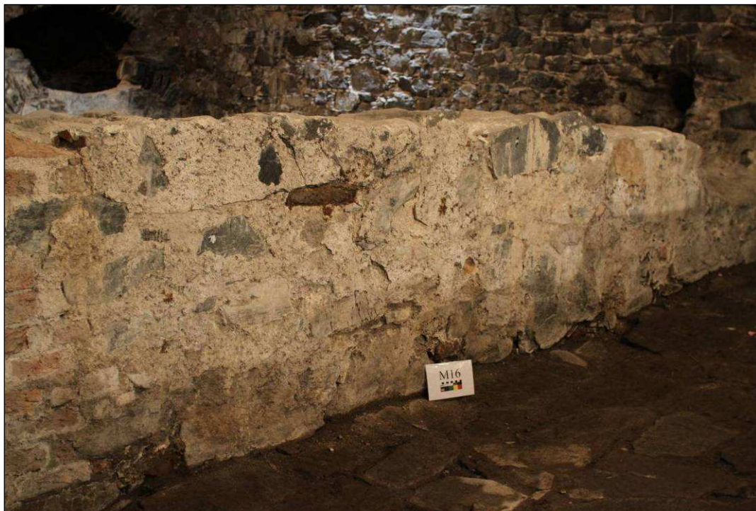
Fig 30. Restene etter et tykt pusslag på nordre murliv i M16 fører til at detaljer i murverket er skjult (foto: Byantikvaren 2009).
