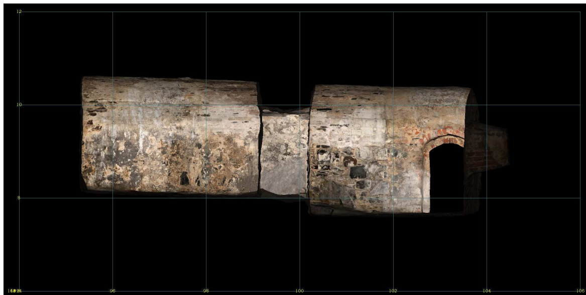
Fig 54. Sørlig murliv i M11. Muren er dekket av et pusslag og delt på midten av en etterreformatorsk skillemur mellom rom 8 og 9 (illustrasjon og oppmåling: Marcin Gladki 2009).
