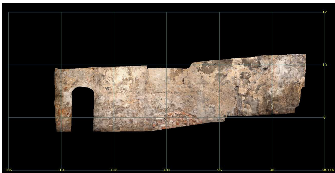
Fig 56. Nordlig murliv M11 inn mot rom 10. Murlivet vendte mot Erkebispegårdens portrom og hovedinngang. Murverket er delvis dekket av et tykt pusslag (illustrasjon og oppmåling: Marcin Gladki 2009).
