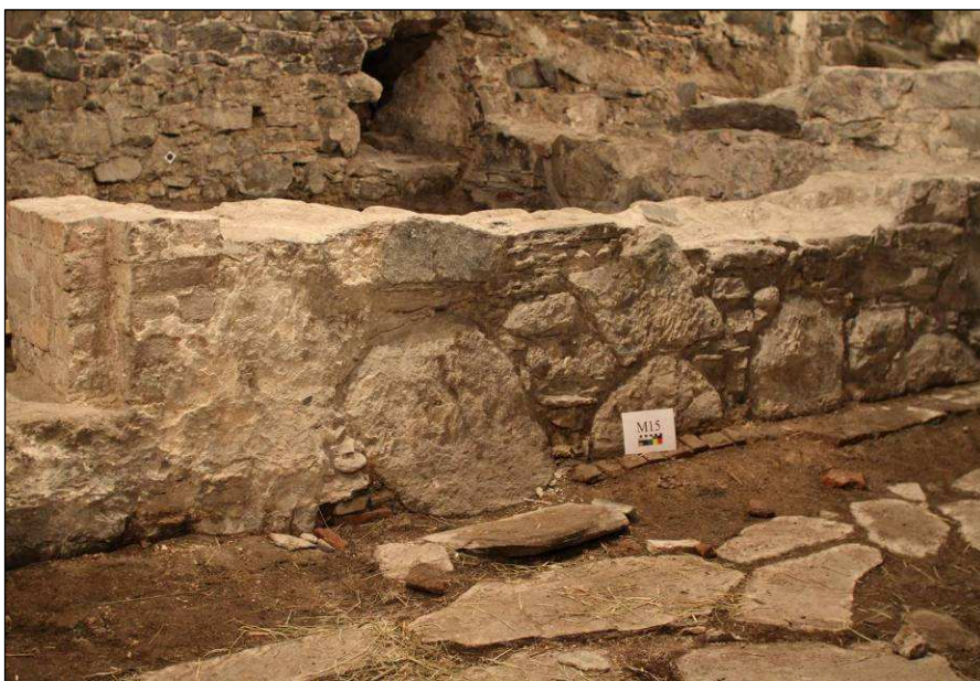
Fig 28. Parti av østre murliv i M15. Merk det kraftige pusslaget og teglforingen i portalen (Å17) som fører inn i rom 12 (foto: Byantikvaren 2009).
