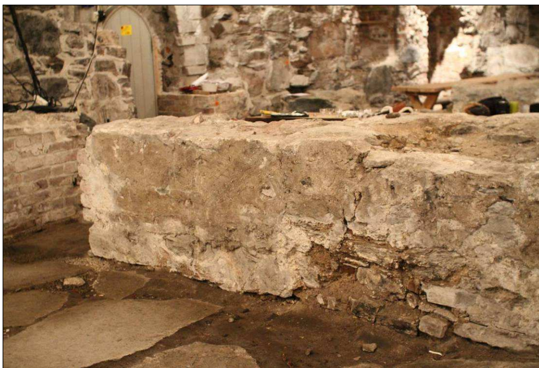
Fig 39. Nordlig parti av M20 med pussdekket nordlig murliv og teglforet portal til venstre. Portalen ble restaurert på 1980-tallet (foto: Byantikvaren 2009).
