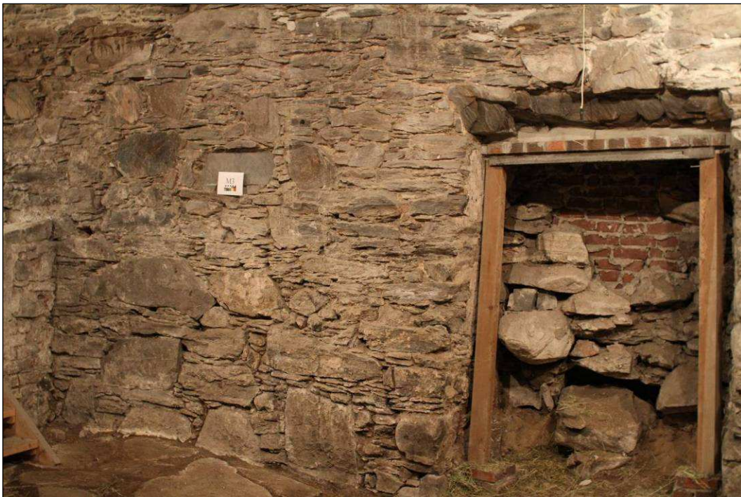
Fig 23. Sørlig del av innerlivet i M3 med en gjenmurt døråpning (Å18). Døråpningen ble sikret med en jernbjelke og et skift med teglstein på 80-tallet (foto: Byantikvaren 2009).
