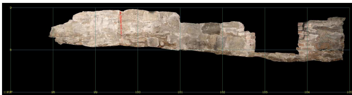
Fig 38. Søndre murliv i M20 med teglforet portal (Å26) i østre del, med innslag mot sør (illustrasjon og oppmåling: Marcin Gladki 2009).
