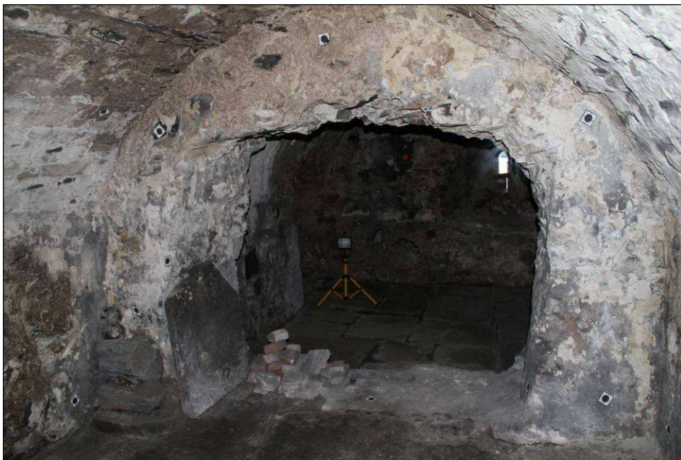
Fig 53. Rester etter skillemur M10, vestlig murliv. Muren er antagelig oppført i forbindelse med gravkjellerne på 1700-tallet (foto: Byantikvaren 2009).
