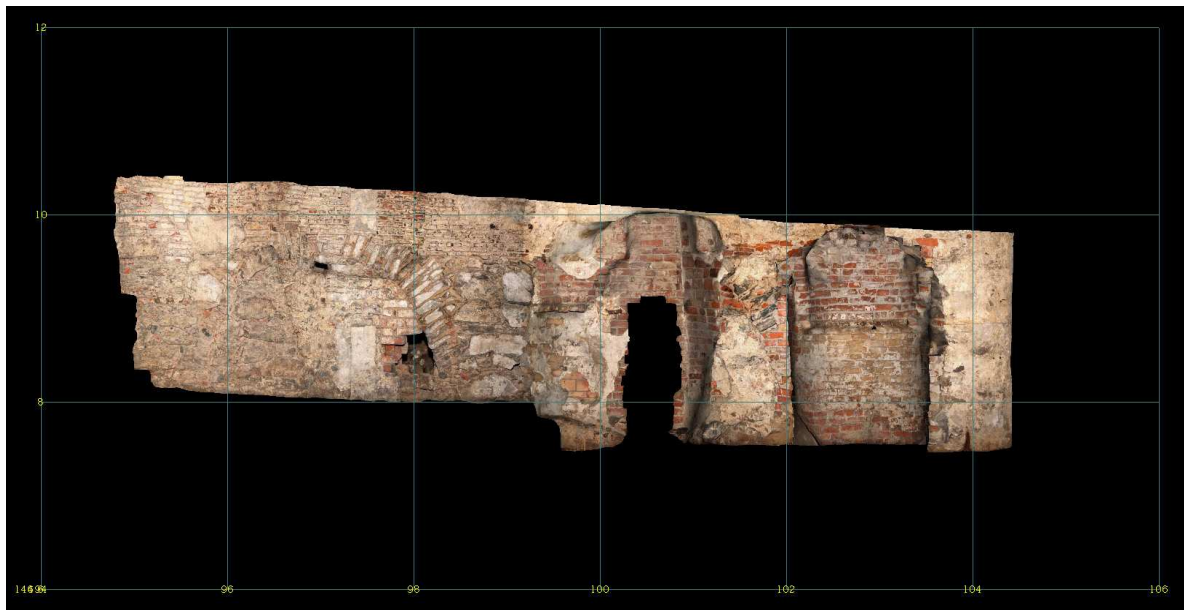
Fig 57. Sørlig murliv i M12 mot rom 10. Muren er opprinnelig middelaldersk men er preget av omfattende ombygginger. I dag er lite av middelaldermurverket bevart midt på muren samt et mindre parti mot vest (illustrasjon og oppmåling: Marcin Gladki 2009).
