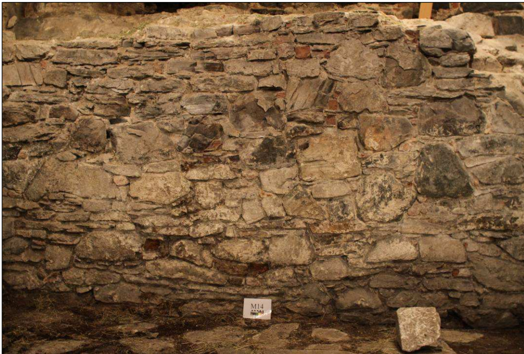
Fig 25. Innerlivet av M14. Muren er etterreformatorisk og er sannsynligvis oppført i forbindelse med hvelving av taket i rom 12 (foto: Byantikvaren 2009).
