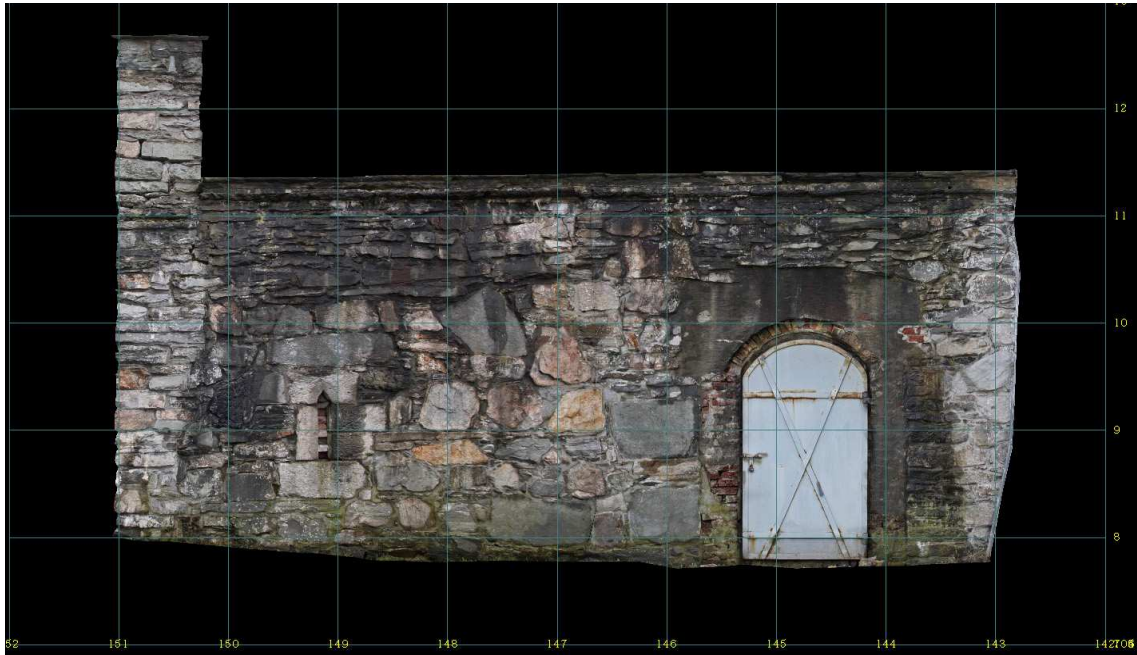
Fig 47. Ytterlivet i terrassen mot øst (M3a) med deler av middelaldermurverk, spissbuet vindusåpning (Å14) og døråpning (Å16) inn til rom 10. Rom 10 var hovedinngang og portrom i middelalderanlegget (illustrasjon og oppmåling: Marcin Gladki 2009).
