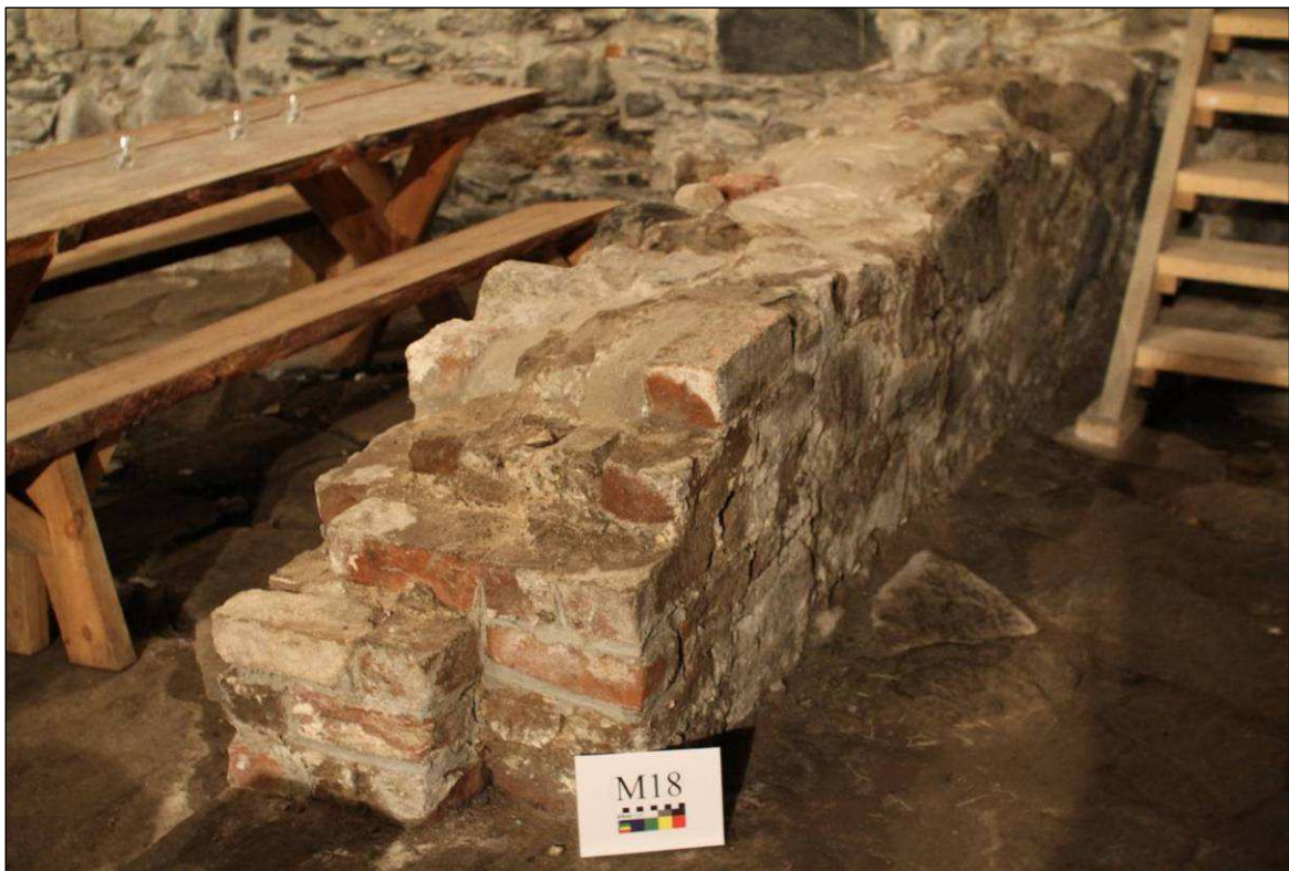
Fig 35. Portalen i M18 er foret med teglstein. Bildet viser sørlig vange i portalen (foto: Byantikvaren 2009).
