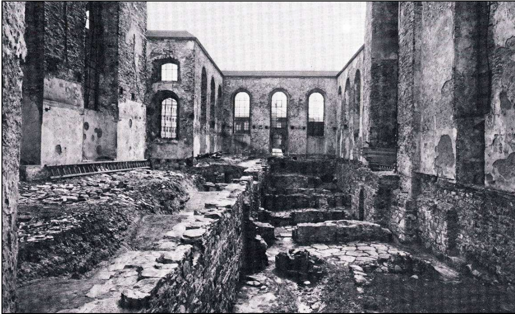
Fig 7. Nykirken ble sterkt skadet ved en eksplosjonsulykke i 1944. Restene av murene i erkebispegården ble da eksponert og på bildet ser en bredden til middelalderanlegget i forhold til kirkebygget over. Foto mot sør (foto: G. Fisher 1948).
