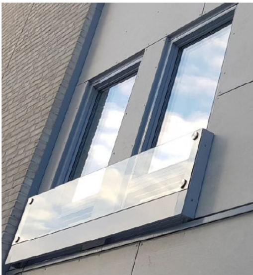
FIGUR 1 Eksempel på fasadeskjerm foran vindu for å oppnå dempet støynivå ved lufting
