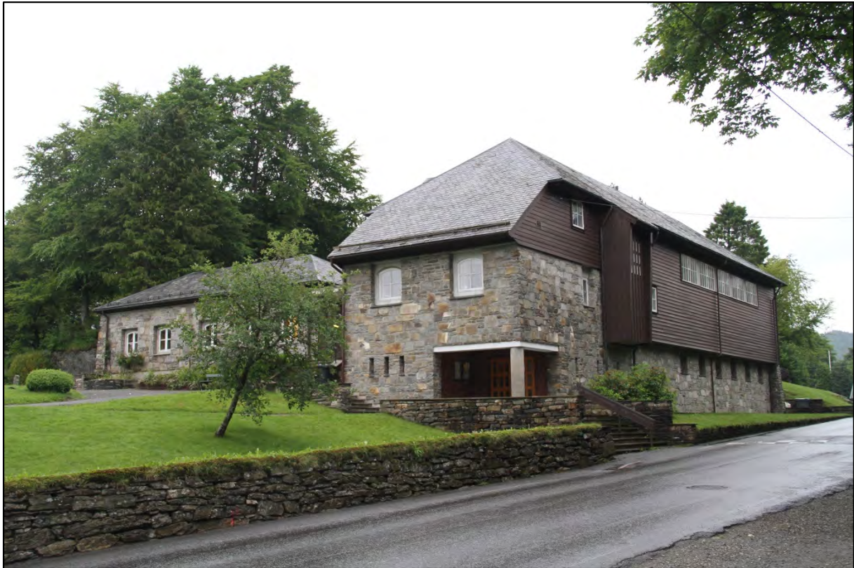
Fig. 8. Menighetshus i tilknytning til Fana kirke bygget i 1960-årene, arkitekt Fredrik Konow Lund (Foto: Byantikvaren)
