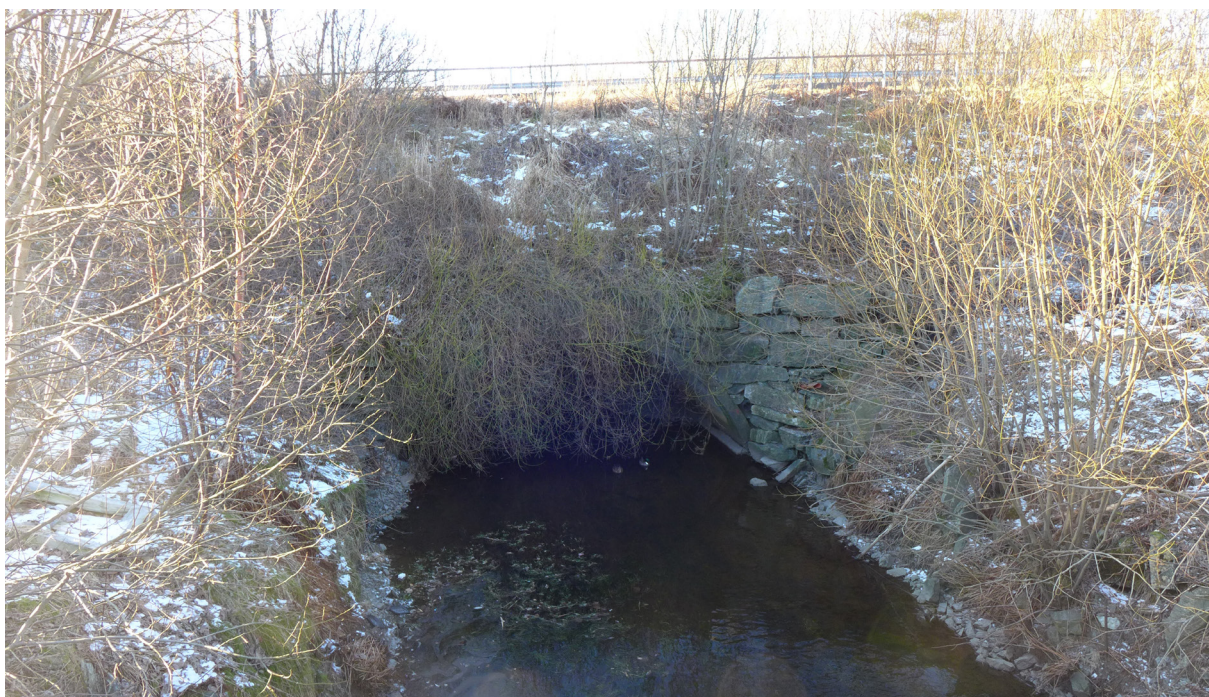
^ Figur 8: Rester av Håbrua er bevart i den nåværende broen. (Foto: UBB-W-F-203150)
