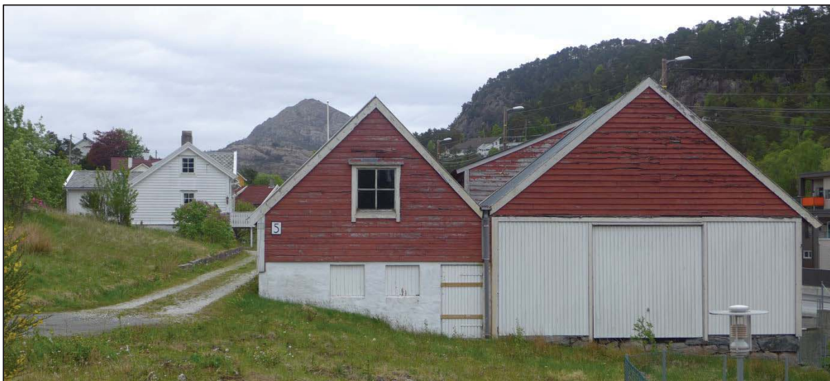
Fig. 8. Sæterdal gård. Driftsbygningen har også innehold snekkerverksted. Foto Byantikvaren 2014.
